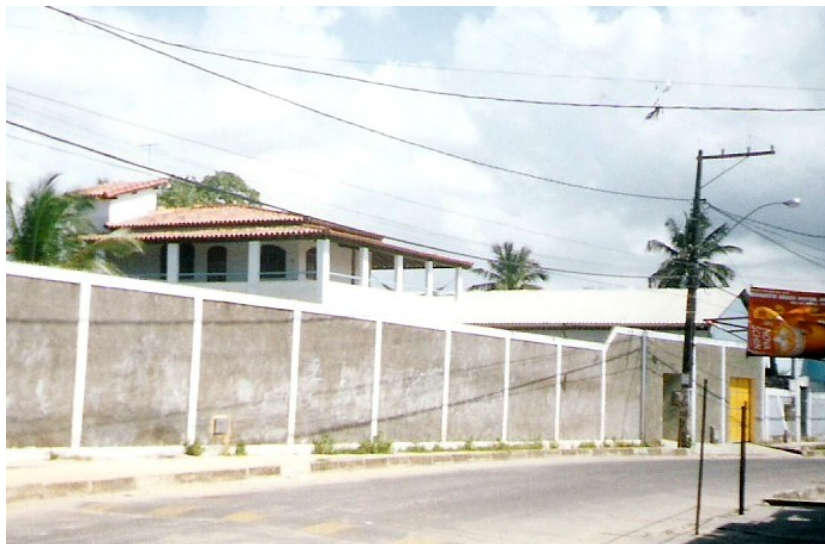
Foto 71 – Araqui, casa de classe média situada na rua Brigadeiro Alberto Costa Matos
