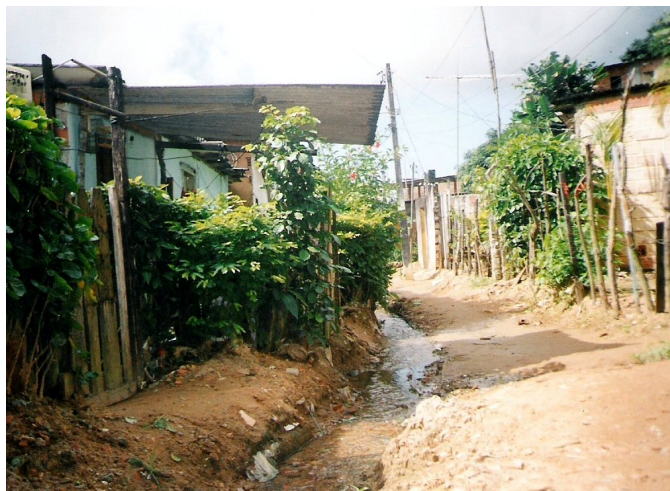
Foto 61 – Loteamento Jardim Talismã, 2ª Travessa Carlos Coutinho
