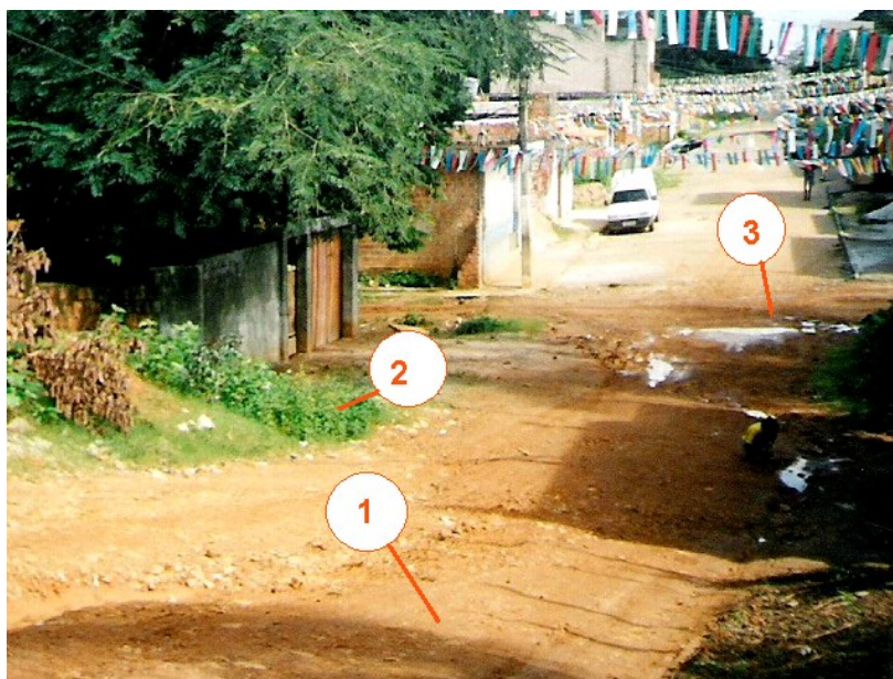
Foto 54 – Loteamento Sayonara, rua José Cardoso dos Santos (“3º trecho”)
