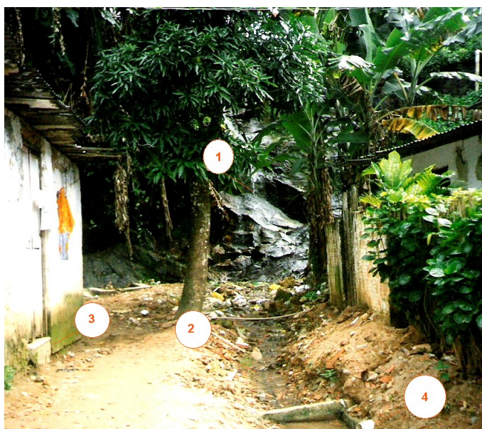
Foto 60 – Loteamento Jardim Talismã, 2ª Travessa Carlos Coutinho
