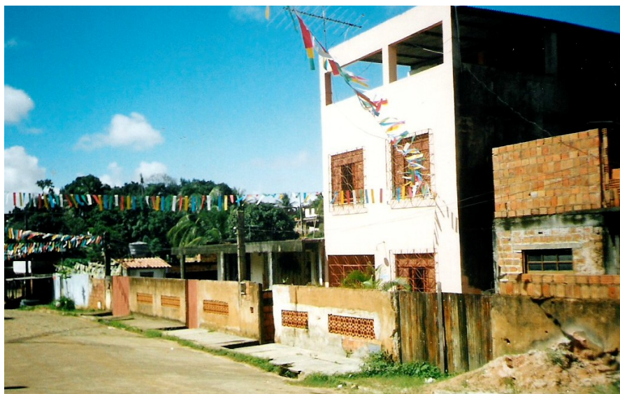
Foto 53 – Loteamento Sayonara, rua José Cardoso dos Santos (“2º trecho”)
