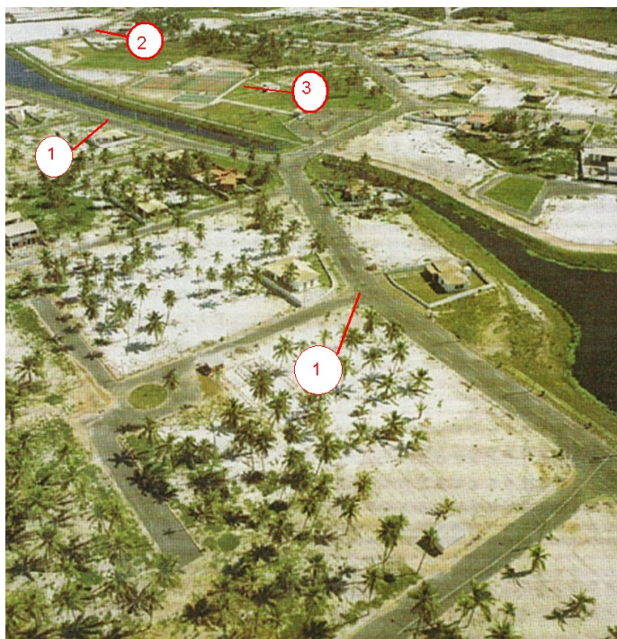
Foto 16 – Vista panorâmica do loteamento Vilas do Atlântico em meados dos anos 1980
