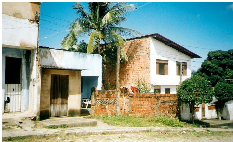
Foto 51 – Loteamento Sayonara, rua José Cardoso dos Santos (“1º trecho”)
