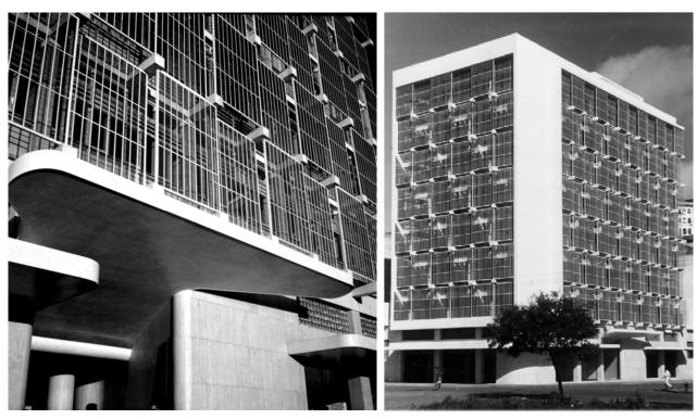
**Figuras 2.77 e 2.78** – Edifício Caramuru: quebra-sóis e marquise do acesso principal, na fachada sudoeste (à esquerda) e vista geral das fachadas noroeste e sudoeste (à direita) Fotos: Pierre Verger (Fontes: FPV – 31870; Arquivo Diógenes Rebouças – CEAB/FAUFBA)
