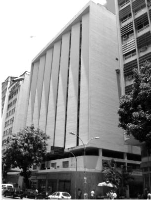
**Figuras 2.79 e 2.80** – Edifício Paraguassú: quebra-sóis com cerca de 27 metros de altura, e marquise horizontal contínua, arredondada nas esquinas – duas vistas a partir da Rua Miguel Calmon: a partir do norte (à esquerda) e do oeste (à direita) (Fotos realizadas pelo autor, 11 fev 2010)
