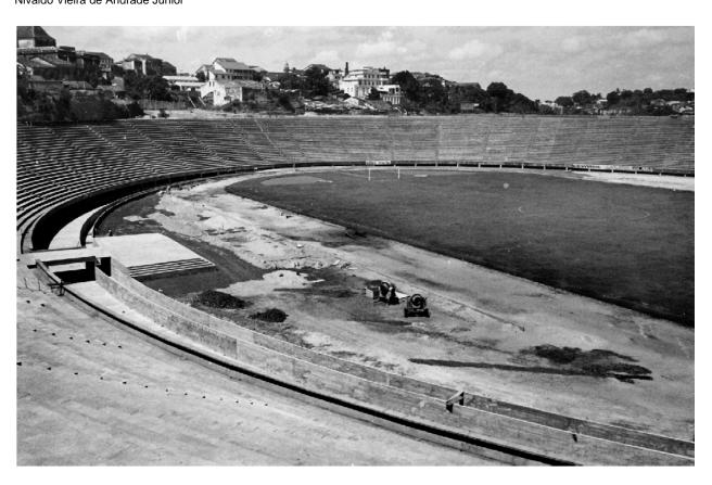
**Figura 2.31** – Estádio da Fonte Nova (Praça de Esportes da Bahia) em construção, com parte da arquibancada (à esquerda e no centro) assentada diretamente sobre a encosta de Nazaré (Fonte: CEAB/FAUFBA)
