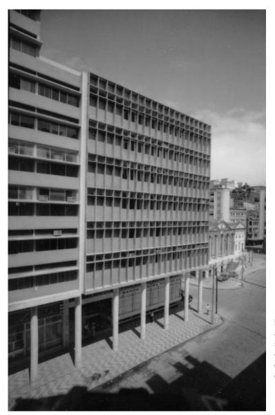
Figura 2.28 – Edifícios construídos no bairro do Comércio entre o final dos anos 1950 e início dos 1960: blocos sobre pilotis, com criação de galerias cobertas, de acordo com as diretrizes do EPUCS e a legislação urbana delas decorrente – à esquerda, Edifício Ouro Preto, à direita, Edifício Almirante Barroso, ambos projetados por Diógenes Rebouças) (Fonte: CDRO)
