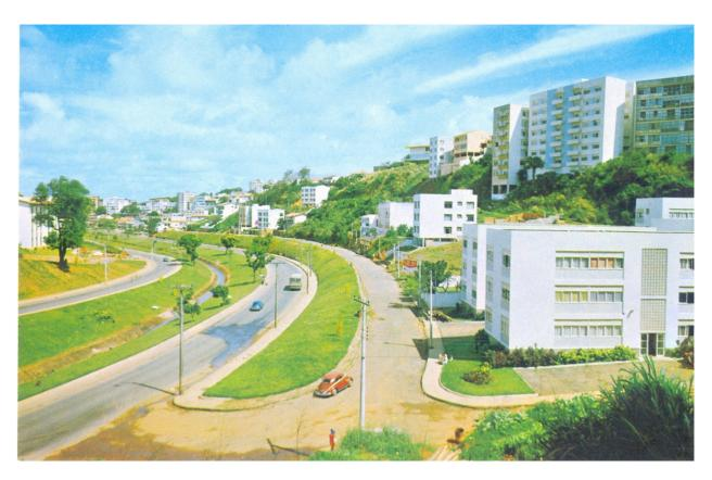
**Figura 2.43** – Avenida do Centenário, sem data: observar as duas vias expressas, nas laterais do talvegue do Rio dos Seixos, canalizado; e a via marginal, de acesso local, onde se encontra o automóvel vermelho; observar ainda a predominância de áreas verdes (Fonte: AHM/FGM)
