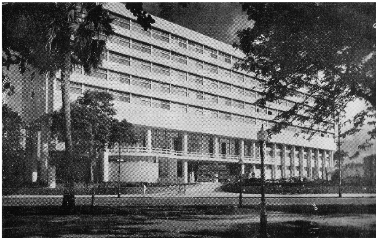
Figura 5.23 – Hotel da Bahia já concluído, visto do Campo Grande (Fonte: SALVADOR, 1951b)
