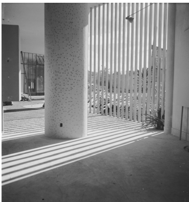
Figuras 5.31 e 5.32 – Interior do Hotel da Bahia: escada de conexão do saguão no térreo para o salão do primeiro pavimento (à esquerda); brise-soleils no salão do primeiro pavimento (à direita) Fotos: Pierre Verger (Fonte: FPV – 29933 FS FS, 29934 FS FS)
