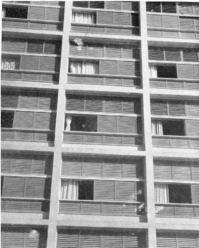
Figura 5.37 – Vista parcial da fachada noroeste do bloco de apartamentos do Hotel da Bahia, com as esquadrias em veneziana de madeira e vidro (Fonte: FONYAT FILHO, 1959)
