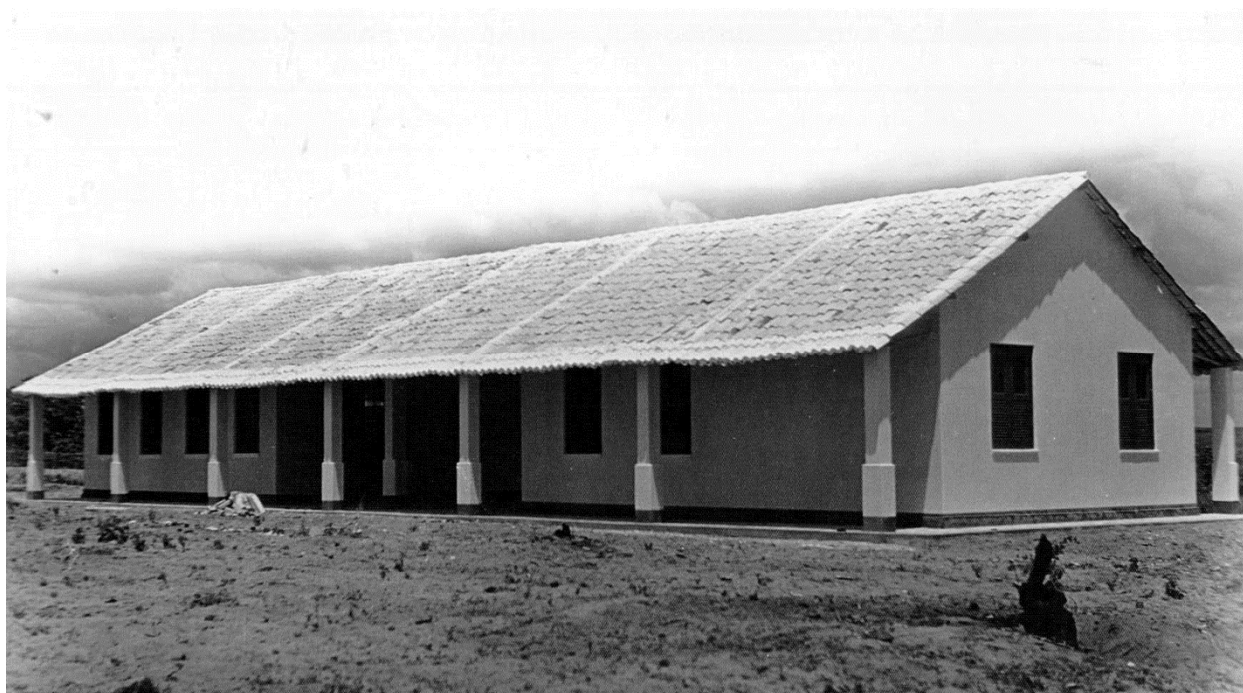
Figura 3.16 – Escola Rural do distrito de Ribeira do Amparo, Município de Cipó, em 1949 – à esquerda está a sala de aula, no centro o recreio coberto e à direita a casa da professora (Fonte: Leão Rozemberg – Arquivo Clemente Mariani, CPDOC/FGV – CMaFOTO 098_9)
