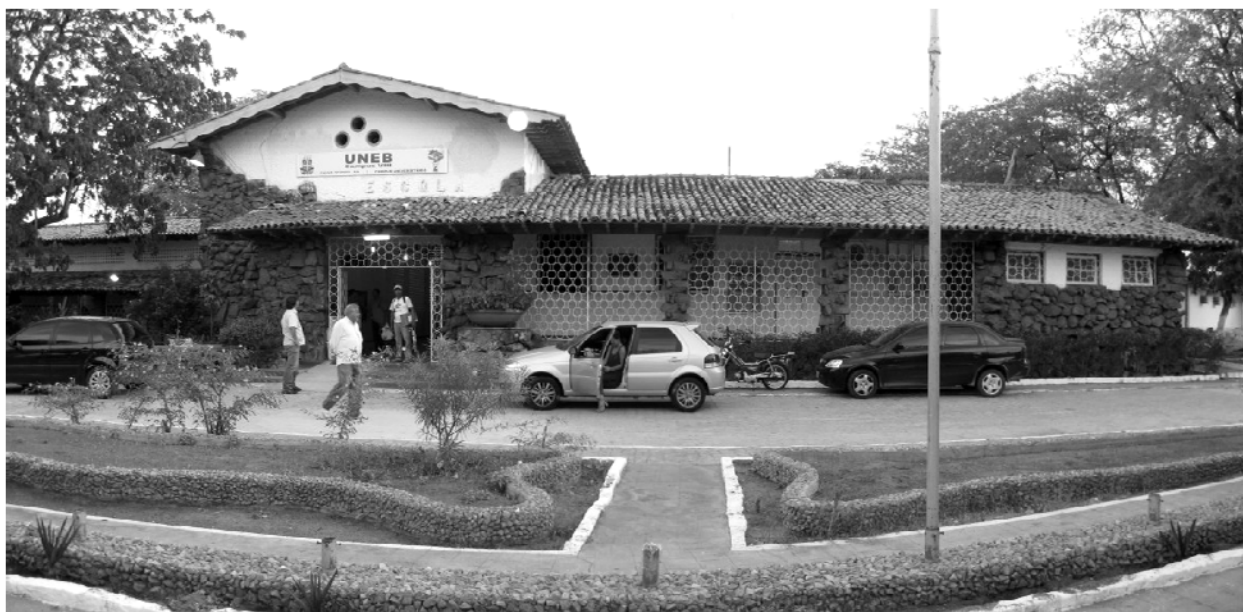
Figura 3.78 – Antiga Escola Adozindo Magalhães de Oliveira, construída pelo Governo Federal em Paulo Afonso e inaugurada em 1949 – atual Campus Universitário VIII da Universidade do Estado da Bahia – UNEB (Foto realizada pelo autor, 04 fev 2010)
