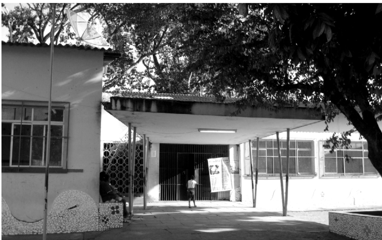
Figura 3.49 – Escola-Classe II: trecho da fachada norte com marquise de acesso apoiada em pilotis metálicos em “V” (Foto realizada pelo autor, 12 ago 2010)
