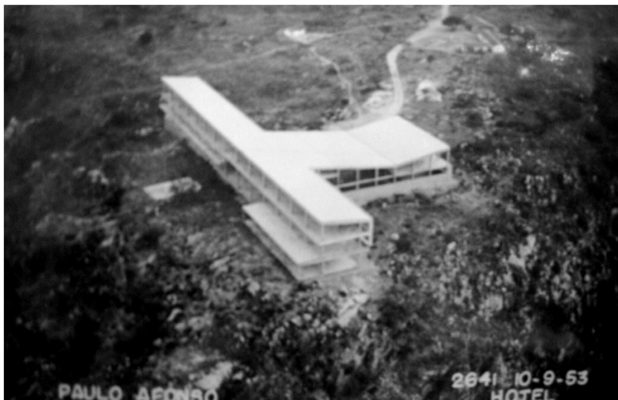
Figura 5.54 – Vista aérea do Hotel Paulo Afonso, já com todo o esqueleto de concreto erguido, em 10 de setembro de 1953 (Fonte: Memorial da CHESF, Paulo Afonso)
