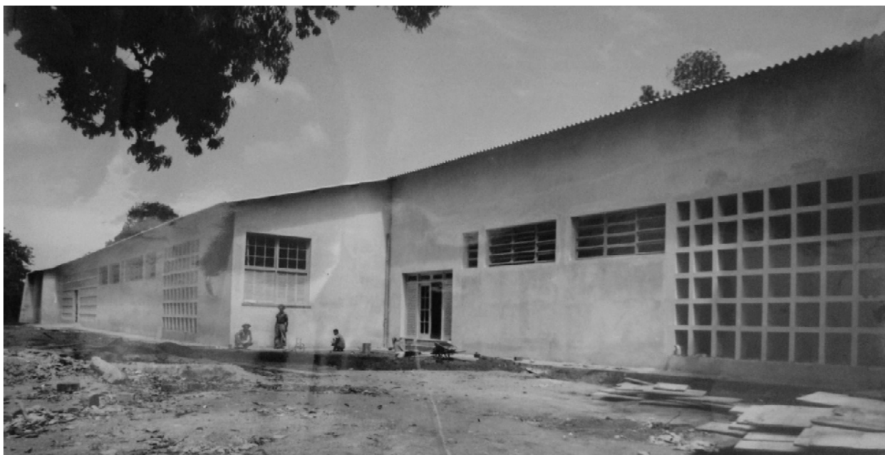
Figura 3.48 – Escola-Classe II: vista geral da fachada sul, mostrando a articulação entre as alas oeste (à esq.) e leste (à dir.) (Fonte: Acervo do CECR – Escola-Parque)
