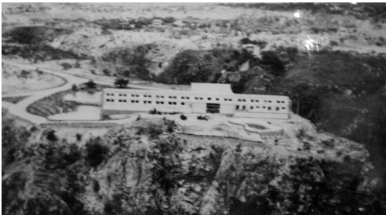
Figura 5.63 – Vista geral da fachada leste do Hotel Paulo Afonso, em 20 de janeiro de 1971, após execução das esquadrias dos apartamentos e do hall de forma distinta àquela prevista no projeto de Rebouças (Fonte: Memorial da CHESF, Paulo Afonso)
