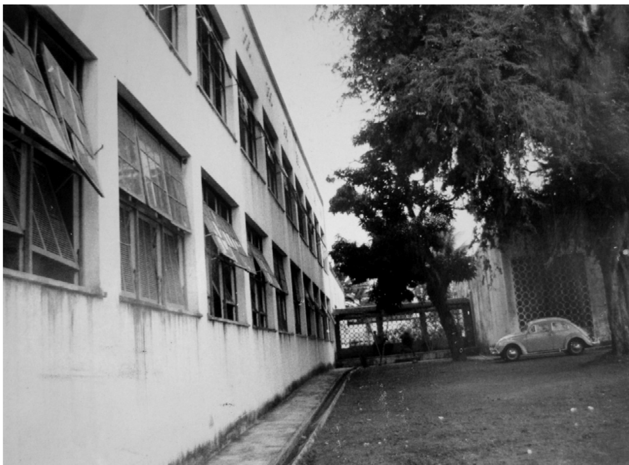
Figura 3.54 – Escola-Classe III: fachada norte do bloco de classes (à esq.) e do bloco administrativo (à dir.); conectando os dois blocos, uma passagem coberta (Fonte: Acervo do CECR – Escola-Parque)
