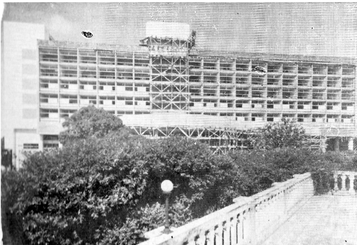
Figura 5.11 – Hotel da Bahia em obras, vista do Passeio Público (Fonte: SALVADOR, 1951b)
