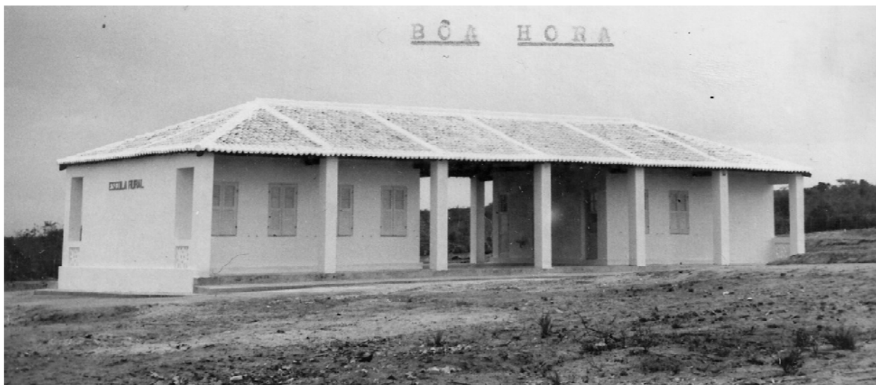
Figura 3.17 – Escola Rural do distrito de Bôa Hora, Município de Cipó, com a cobertura em quatro águas, distinta do projeto padrão do INEP – à esquerda, vê-se a sala de aula, no centro o recreio coberto e, à direita, a casa da professora (Fonte: Acervo da família Accioly Vieira de Andrade)
