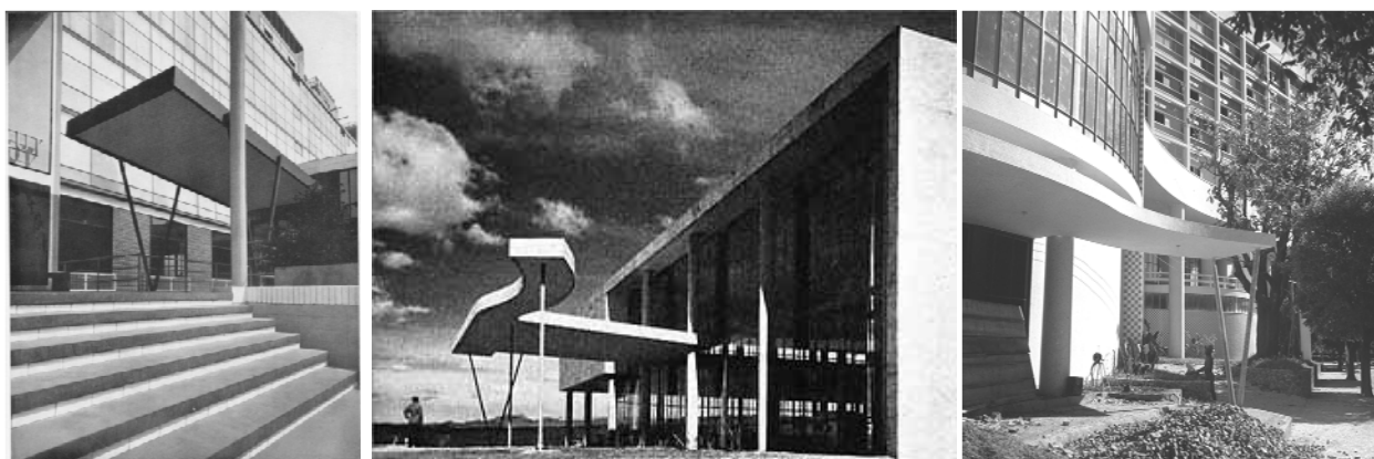
Figuras 5.39, 5.40 e 5.41 – Três marquises apoiadas em pilotis em “V”: Cité de Refuge em Paris, de Le Corbusier, 1932-1933 (à esquerda); Cassino da Pampulha em Belo Horizonte, de Oscar Niemeyer, 1942 (centro) e restaurante típico do Hotel da Bahia em Salvador, de Diógenes Rebouças e Paulo Antunes Ribeiro, 1947-1951 (à direita) (Fontes: BOESIGER, 1952; GOODWIN, 1943; foto do Hotel da Bahia de Pierre Verger – FPV – 29899 FS FS)
