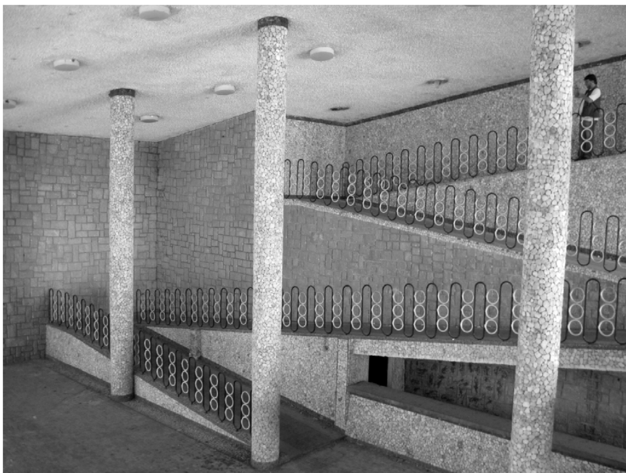
Figura 5.64 – Vista geral do hall do Hotel Paulo Afonso, em seu estado atual (Foto realizada pelo autor, 05 fev 2010)
