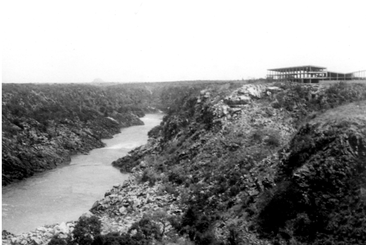
Figura 5.53 – Vista do Hotel Paulo Afonso em construção, a partir da Usina da CHESF (Fonte: Arquivo da Superintendência do IPHAN/BA, Salvador)
