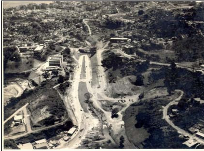
Figura 4.49 - Abertura da Avenida Garibaldi, construída entre 1969-1972 Fonte: RCGR Informática (2002) apud MENDES (2006)
