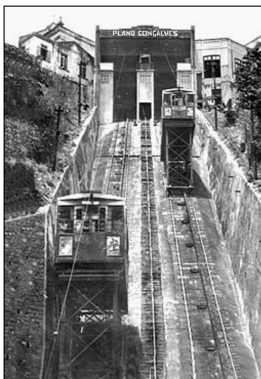
Figura 3.5 – Vista da rampa e cabines do Plano Inclinado Gonçalves em 1931
