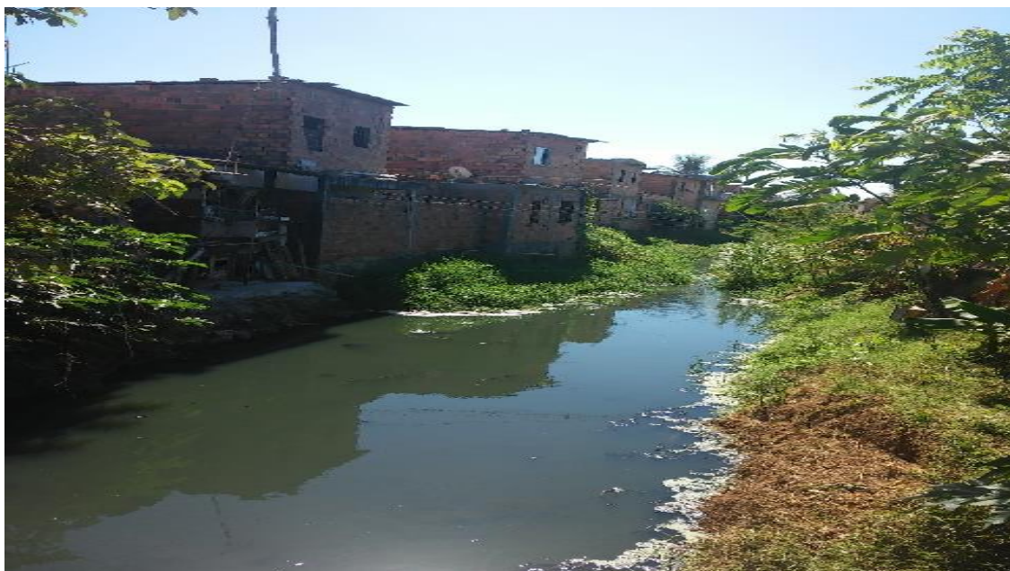
Figura 25 - Construções desplanejadas às margens do rio Ipitanga
