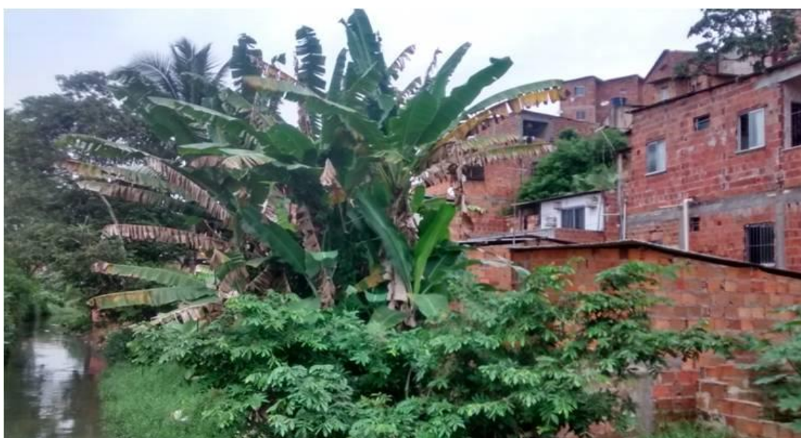
Figura 26 - Construções às margens do rio Ipitanga
