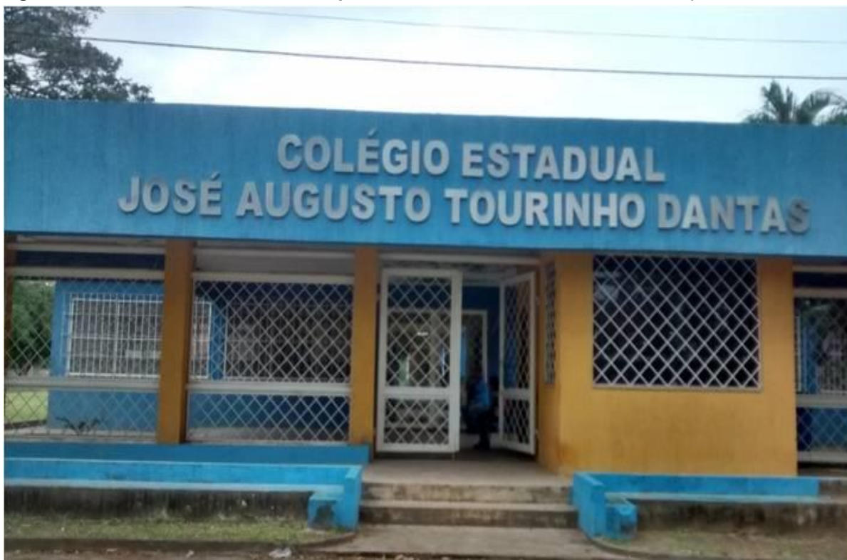
Figura 2 - Frente do CEJATD, acesso para a Rodovia BA 526-Estrada CIA/Aeroporto
