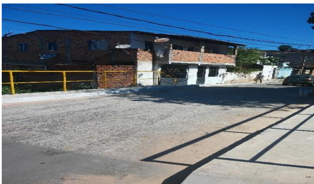
Figura 23 - Rua asfaltada na Fazenda Cassange
