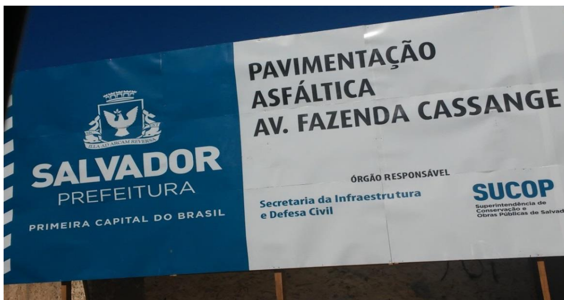
Figura 22 - Placa da prefeitura indicando a pavimentação asfáltica na Fazenda Cassange
