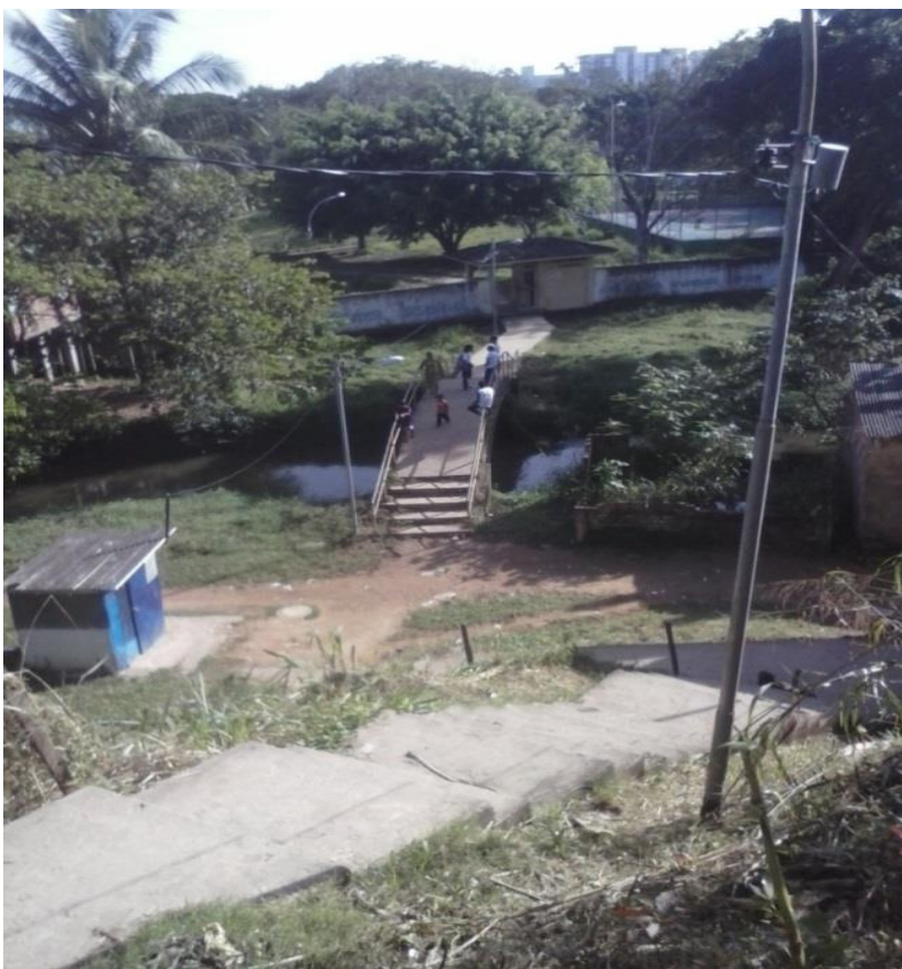
Figura 4 - Escadaria e ponte de acesso entre bairros ao fundo do CEJATD
