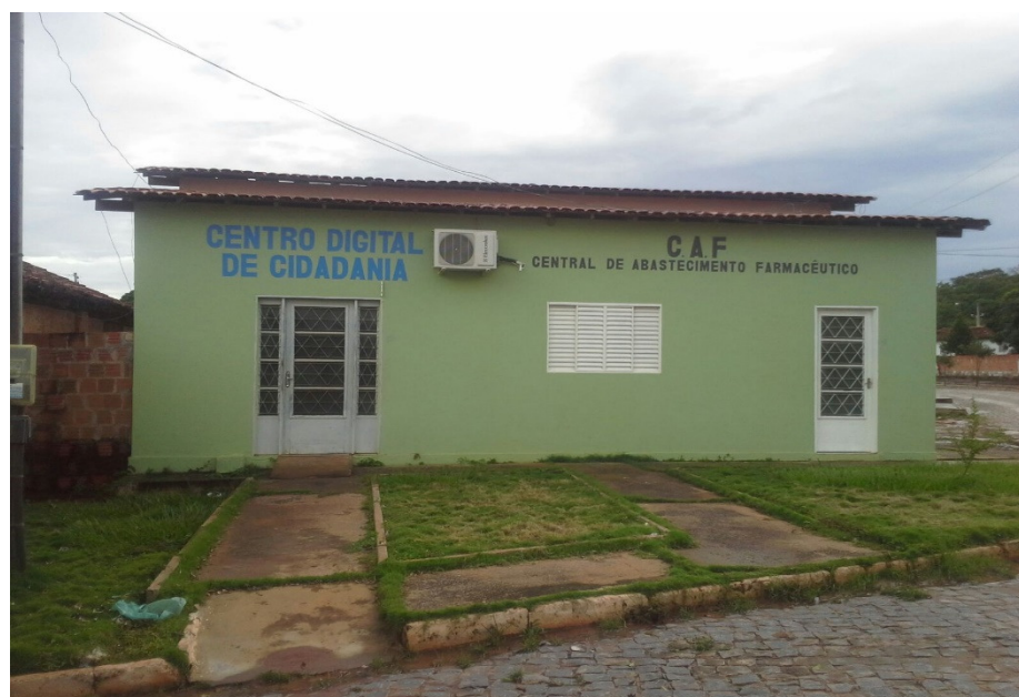
FIGURA XVI. Prédio do Centro Digital de Cidadania e da Central de Abastecimento Farmacêutico (Catolândia, Bahia).
