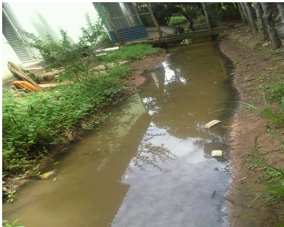
FIGURA XIX. Trecho do Córrego Boa Sorte, na área correspondente à estação 12 (setor 8, na sede municipal, mostrado na Figura VII). Catolândia (Bahia).
