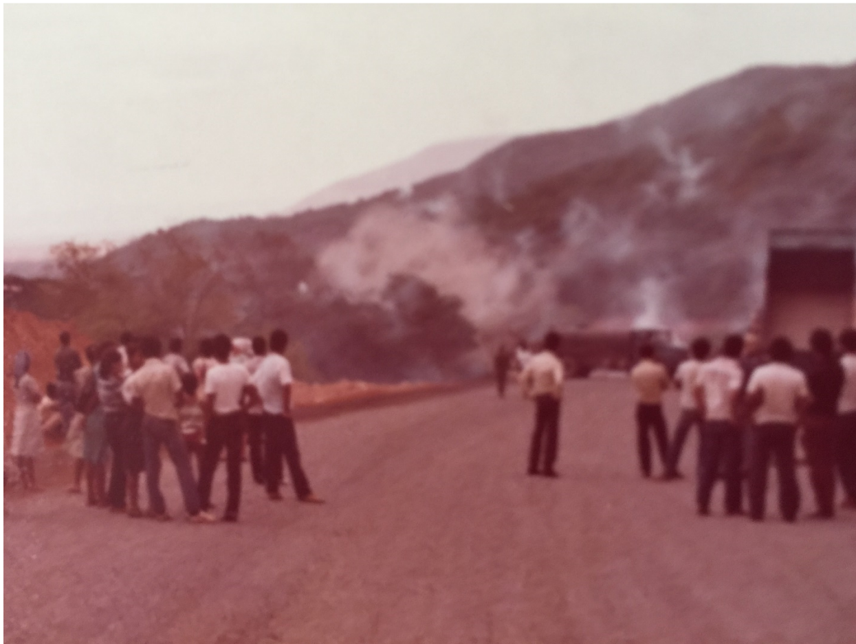
FIGURA XXI. Momento do foguetório dos Soldados e do Comandante do 4º Batalhão de Engenharia de Construção (4º BEC) do Exército do Brasil (Barreiras, Bahia), em comemoração ao término da terraplanagem da Rodovia BR-020 (Rodovia Presidente Juscelino Kubitschek) - no ponto que ligava a estrada a partir de Barreiras com aquela a partir de Brasília (136) .
