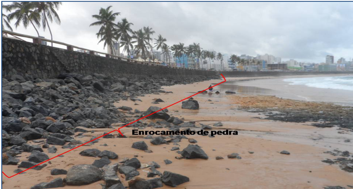
Figura 24: Enrocamento de pedra em trecho de praia da Pituba - Salvador/Bahia.
