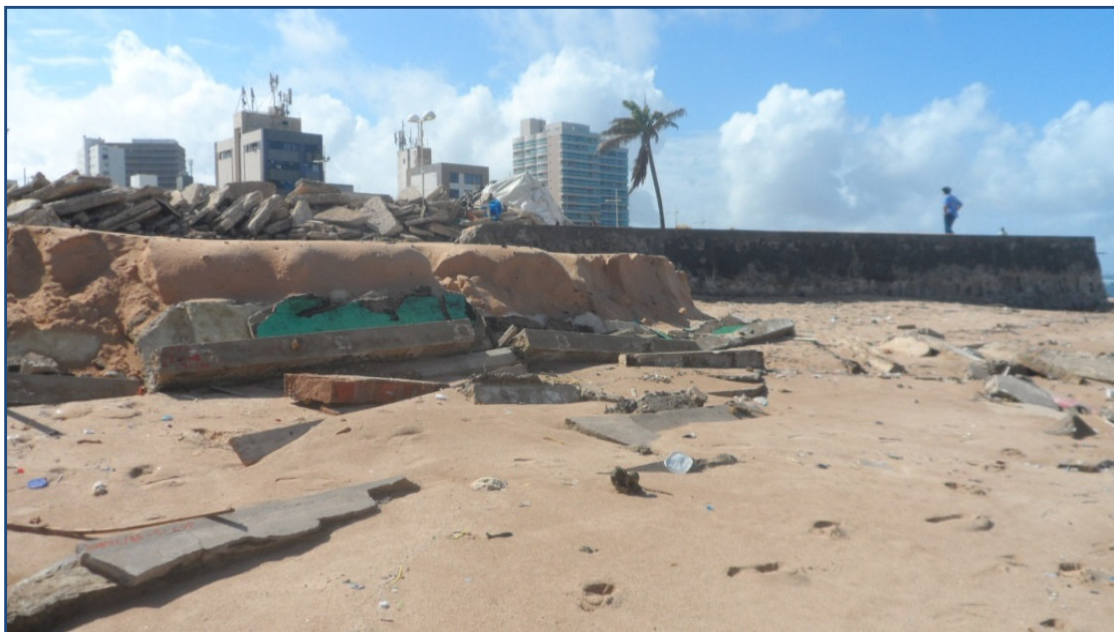
Figura 31: Muro de alvenaria de pedra reconstruído pela prefeitura municipal em trecho de praia da Pituba (II) - Salvador/Bahia, 2015.
