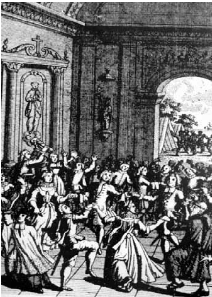
Figura 3 – Interior da Capela Gonçalo
