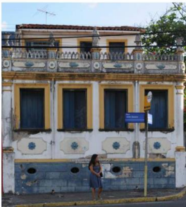
Figura 13 - Residência na Rua João Gomes
