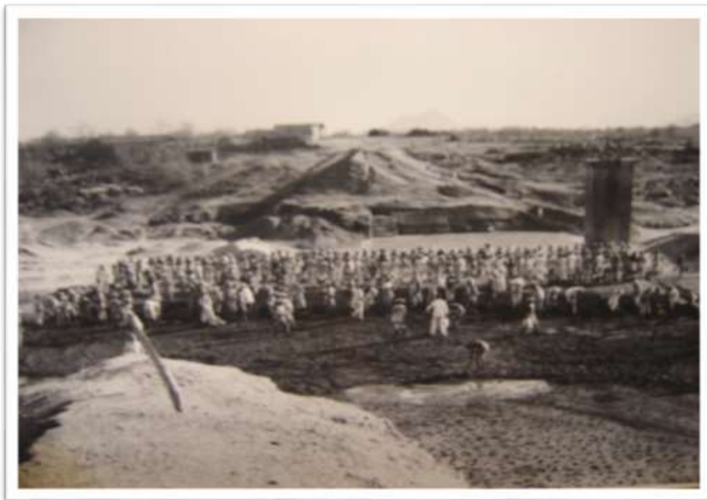
Fotografia 3. Trabalhadores na reconstrução do açude Patos (CE-dezembro de 1953)
