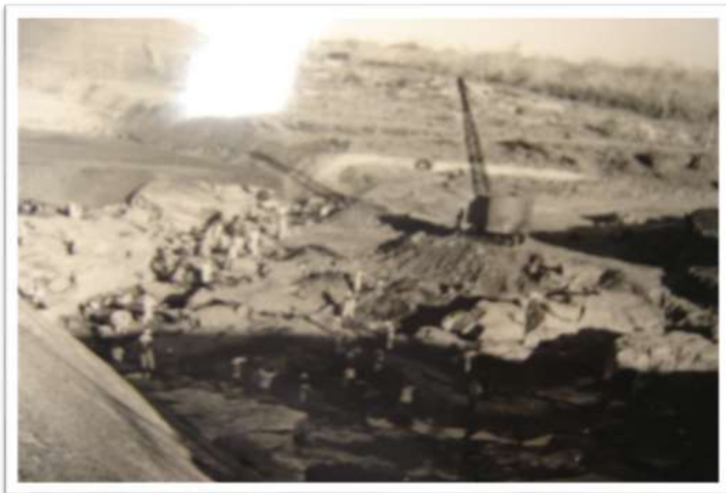
Fotografia 4. Trabalhadores na Cava de Fundação Açude Jucuruci (BA)
