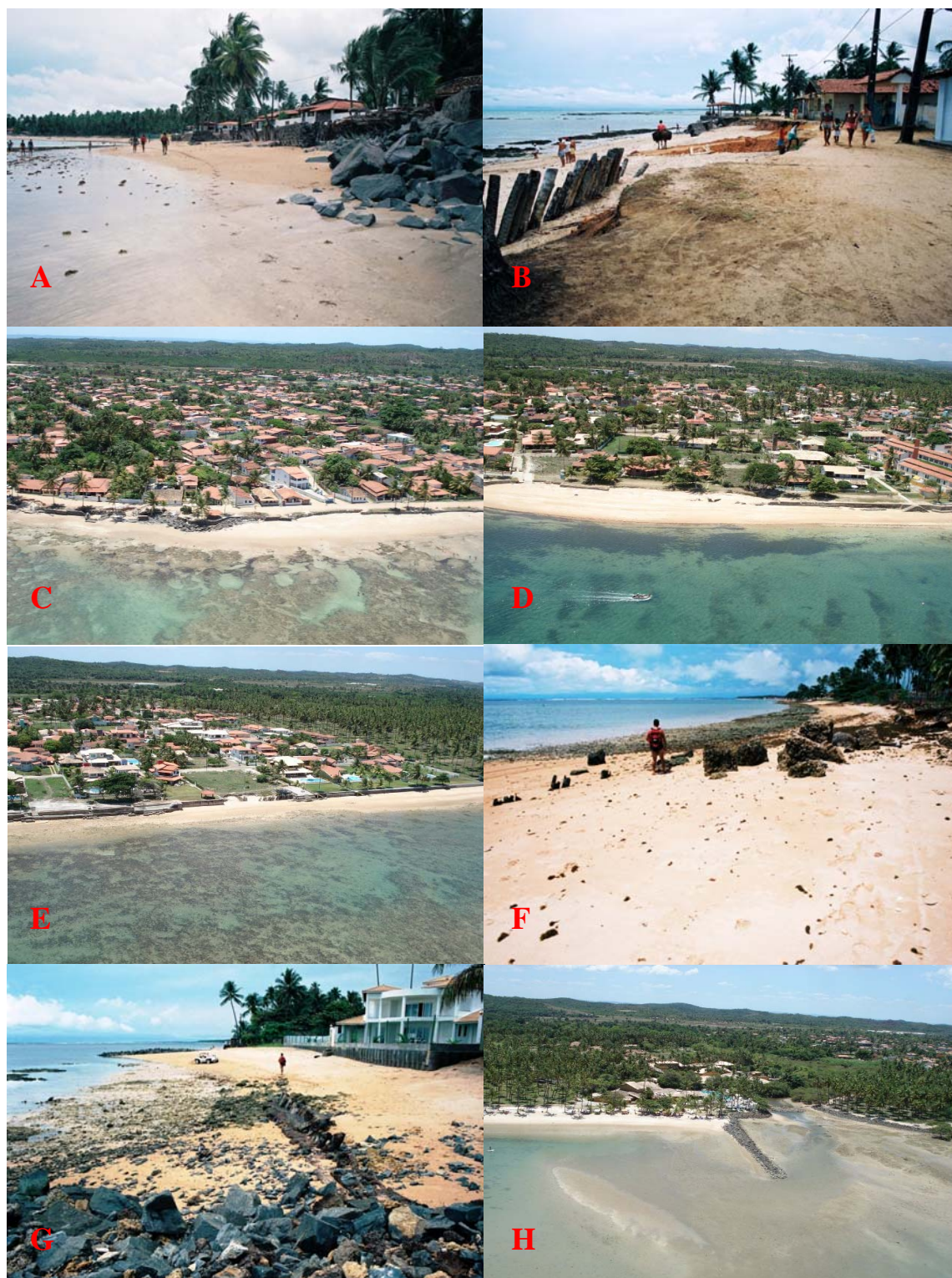
Figura 14: Trechos costeiros sob erosão entre a praia do Condomínio Ilha Bela e o Club Med. A e B – Destruição de obras de contenção e o avanço do mar sobre uma rua na praia dos Corais. Note a escarpa a cerca de 2 metros da estrutura eletrificação e das casas; C – Vista aérea da praia dos Corais mostrando muros caídos e um enrocamento instalado na tentativa de conter o avanço do mar sobre a rua D e E – Vista aérea da praia do Sol e de Barra Grande mostrando a destruição de muros de contenção instalados na linha de costa; F e G – Restos de antigas construções expostas na face da praia no trecho imediatamente a sul do Club Med e, H – Espigão transversal defronte ao Club Med construído com objetivo de reter sedimentos, mas que não responde da forma esperada.
