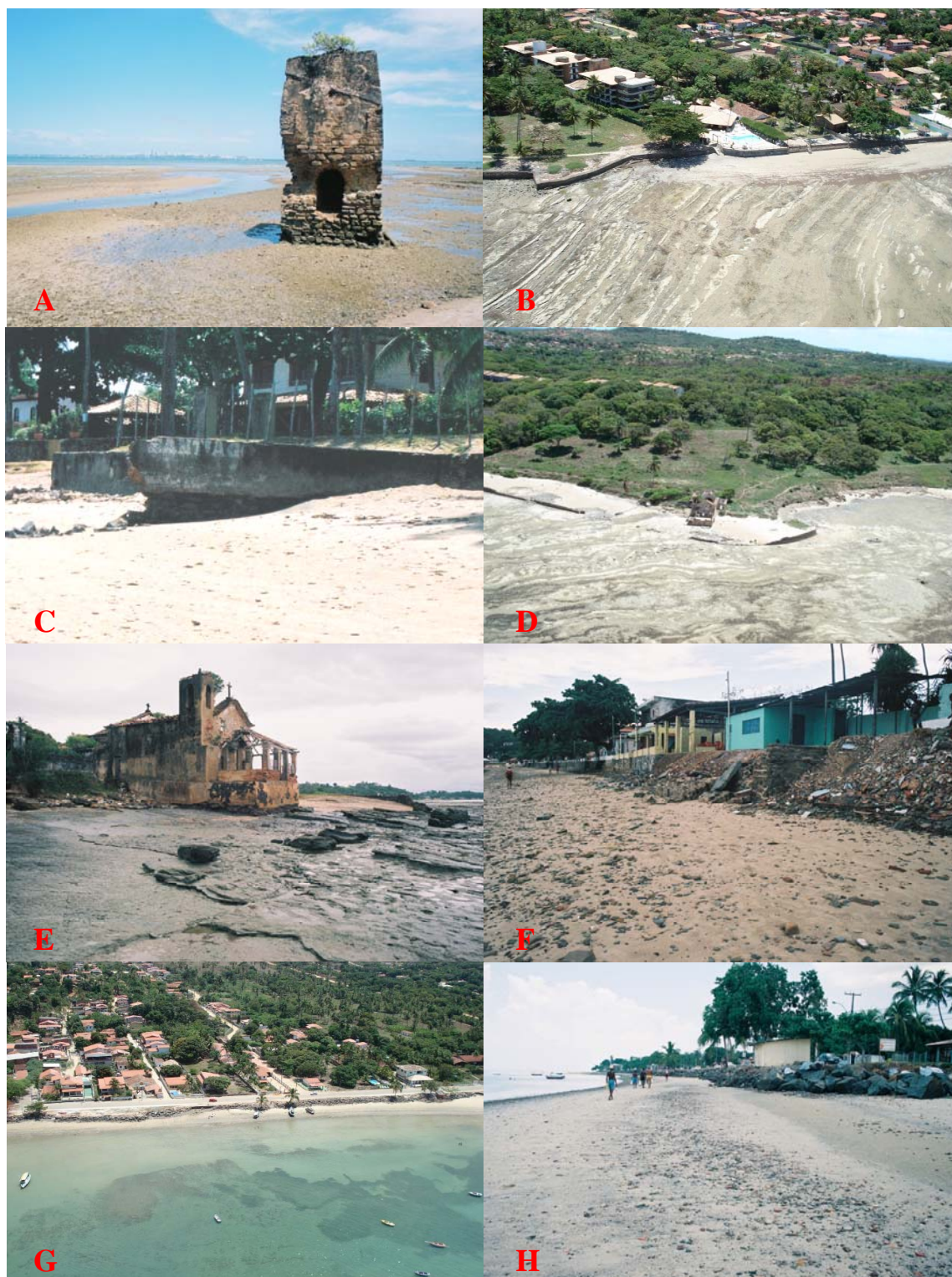
Figura 41: A – Resto de antiga construção na face da praia na Penha; B e C – Grandes muros de contenção protegendo as casas da destruição e restos de construção na face da praia entre a Penha e Mar Grande; D e E – Restos de uma antiga igreja e do muro de contenção que a protegia, próximo a praia do Buraco Boi; Escombros de muro defronte aos bares na praia de Gameleira e; G e H – Enrocamento protegendo a via de acesso e as barracas de praia da destruição em Amoreiras.
