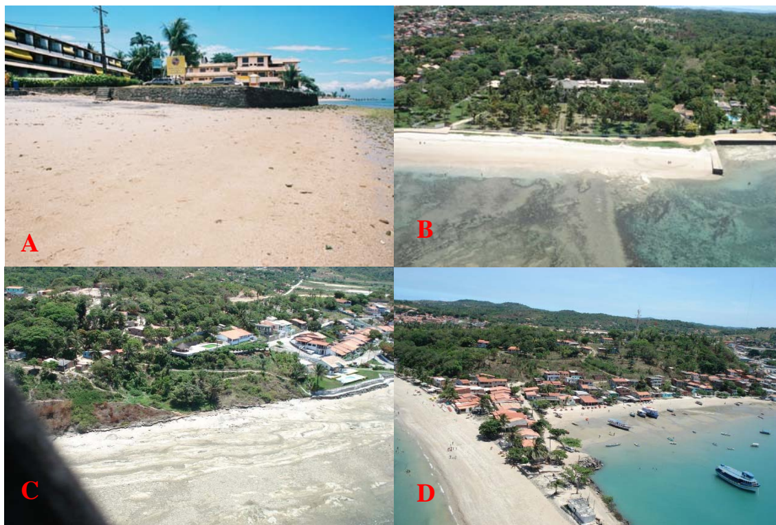
Figura 21: A – Muro de arrimo de um Hotel sob a face de praia, próximo a Mar Grande, construído de forma irregular indicando uma falsa situação de progradação da linha de costa no transecto 301; B – acúmulo de sedimento a barlamar de um espigão transversal construído ao norte da Ponta do Jaburu (transecto 318); C – Obras de contenção em Gameleira (transecto 340) e, D – Construções irregulares sob o terraço arenoso acumulado após a construção do espigão do terminal marítimo de Bom Despacho (transecto 350).
