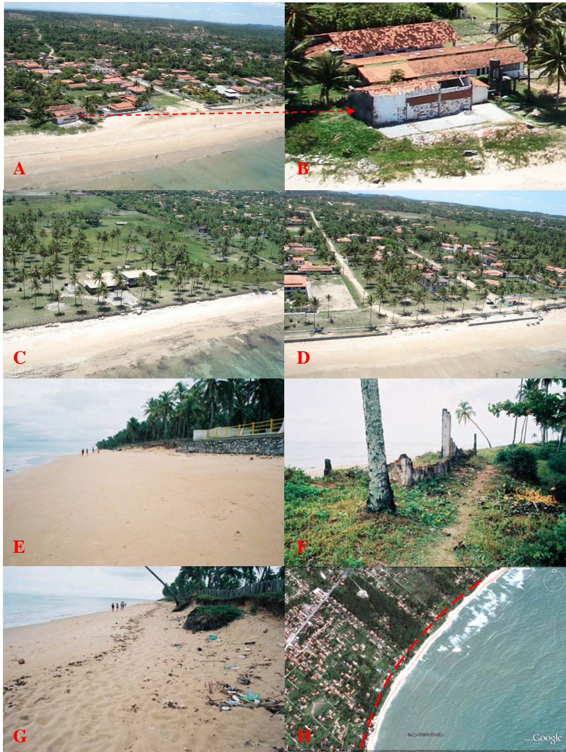
Figura 11: Trechos costeiros sob erosão no setor 2: A e B – Casa parcialmente destruída no local onde foi posicionado o transecto 79, próximo a Berlinque; C, D e E - Destruição de muros de contenção com recuo da linha de costa em suas extremidades em Aratuba; F – Ruína de uma antiga casa que existia no trecho de Aratuba; G – Raízes de coqueiros expostas e coqueiros tombados em Aratuba;; H- Imagem de satélite mostrando terraço arenoso em meio às construções, próximo a Tairu. Linha vermelha representa a posição da linha de costa em 1959 (Ver figura 9).
