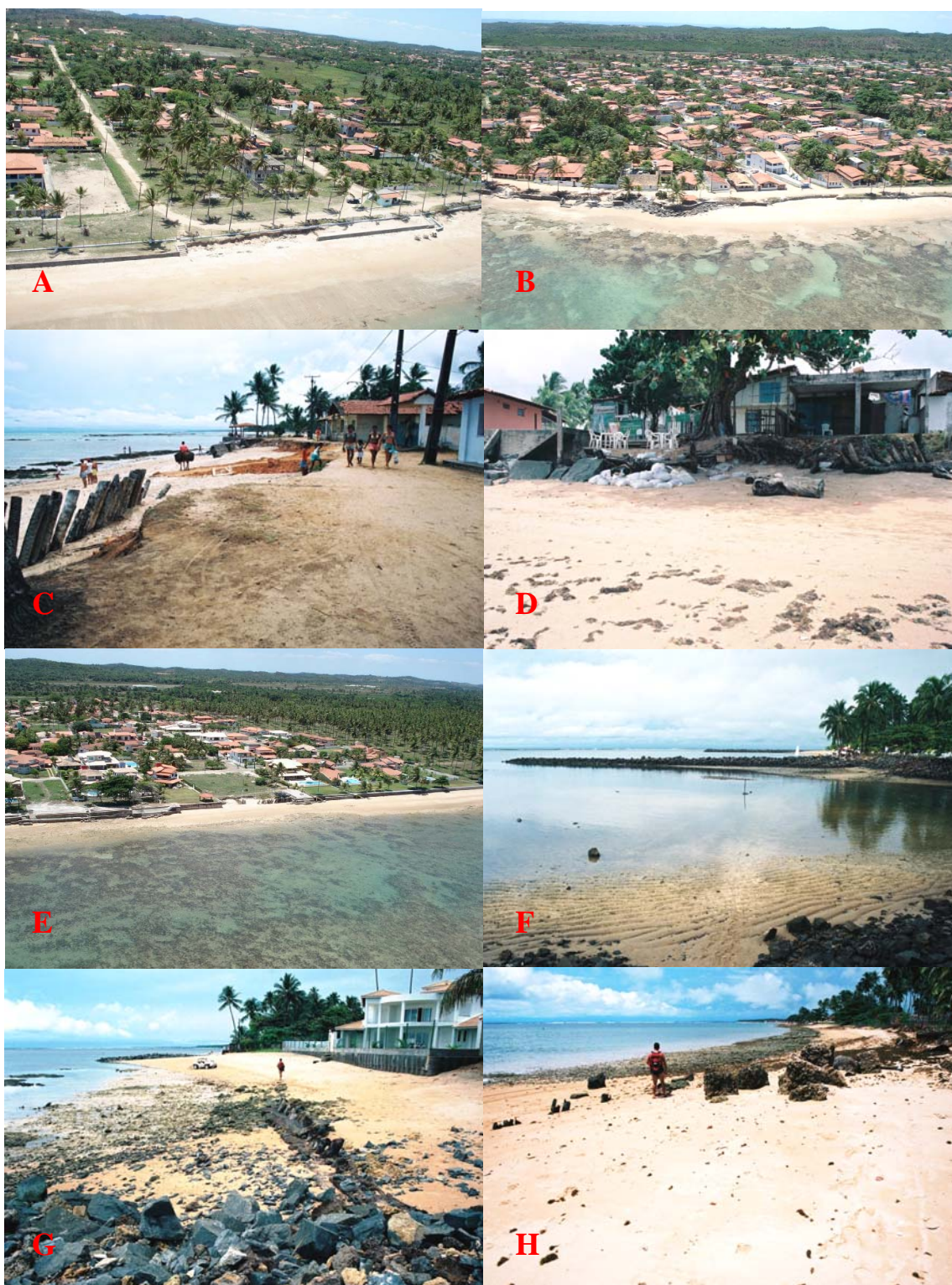
Figura 40: A - Destruição de muros de contenção defronte as casas em Aratuba; B – Vista aérea da praia dos Corais, em Barra Grande, mostrando enrocamento instalado na tentativa de conter a erosão; C e D – Destruição de obras de contenção e o avanço do mar sobre uma rua na praia dos Corais, em Barra Grande; E – Destruição de obras de contenção e muros defronte as casas em Barra Grande; F – Molhes transversais construídos para conter o avanço do processo de erosão no Club Med; G e H – Restos de antigas construções na face da praia no trecho imediatamente a sul do Club Med.
