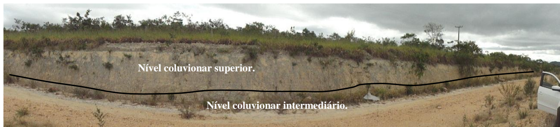
Vista geral do afloramento
