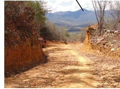
Vista geral das vertentes recobertas por depósitos coluvionares
