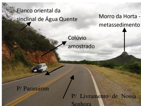
Vista geral da vertente recoberta por depósito coluvionar.
