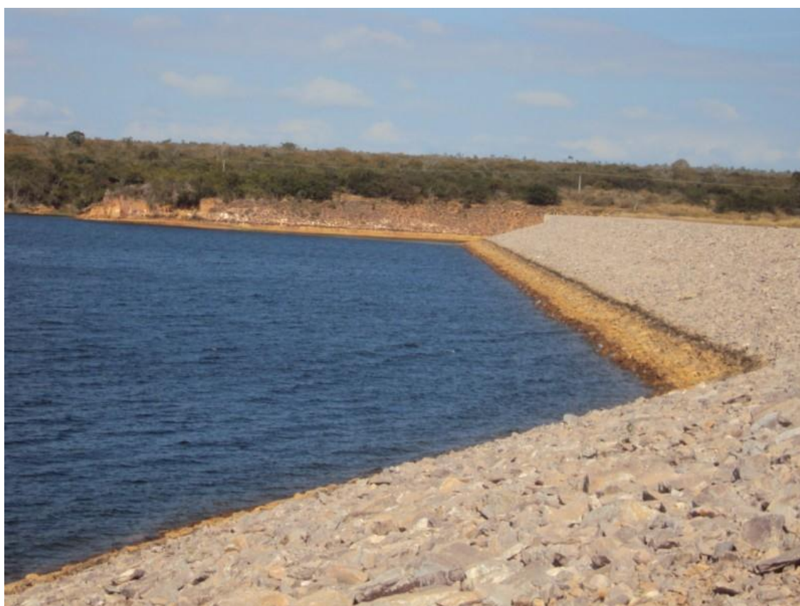
FOTO 1: Barragem do Apertado. Fonte: BAHIA_CERB, 2014.
