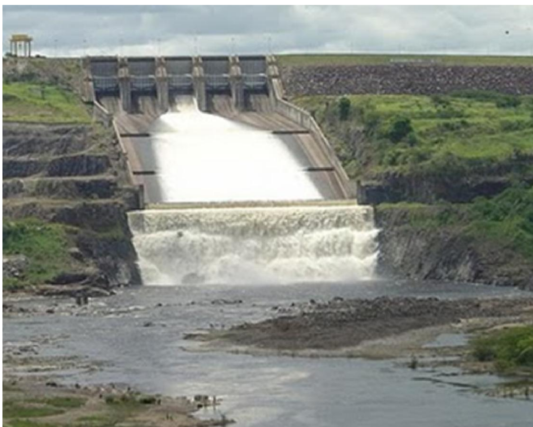
Foto 3: Barragem de Pedra do Cavallo. Fonte: GOOGLE, 2014.
