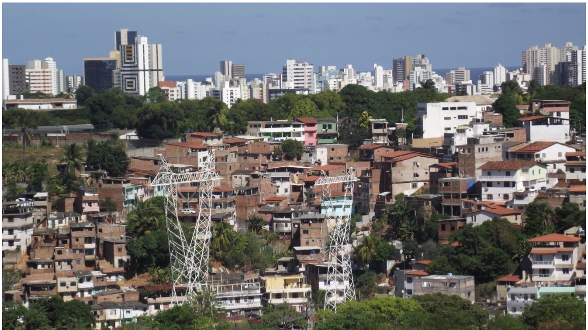
Foto 13 - Predominância da autoconstrução na área da Caiçara, encosta do Planalto de Brotas.
