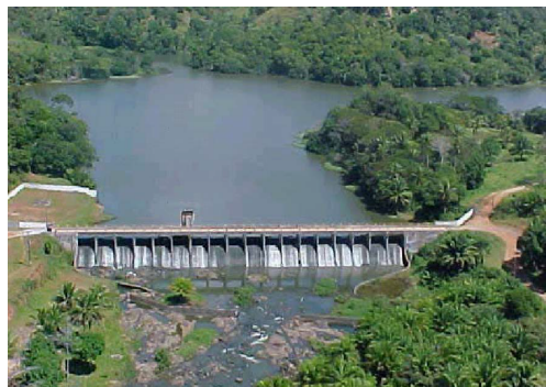
Foto 4 - Vista aérea da Barragem Joanes II.
