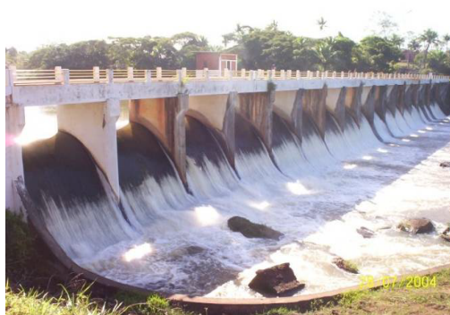
Foto 3 - Barragem Joanes I.
