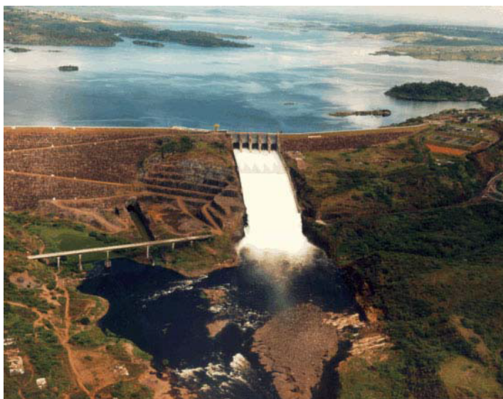
Foto 11 - Vista da Barragem de Pedra do Cavalo
