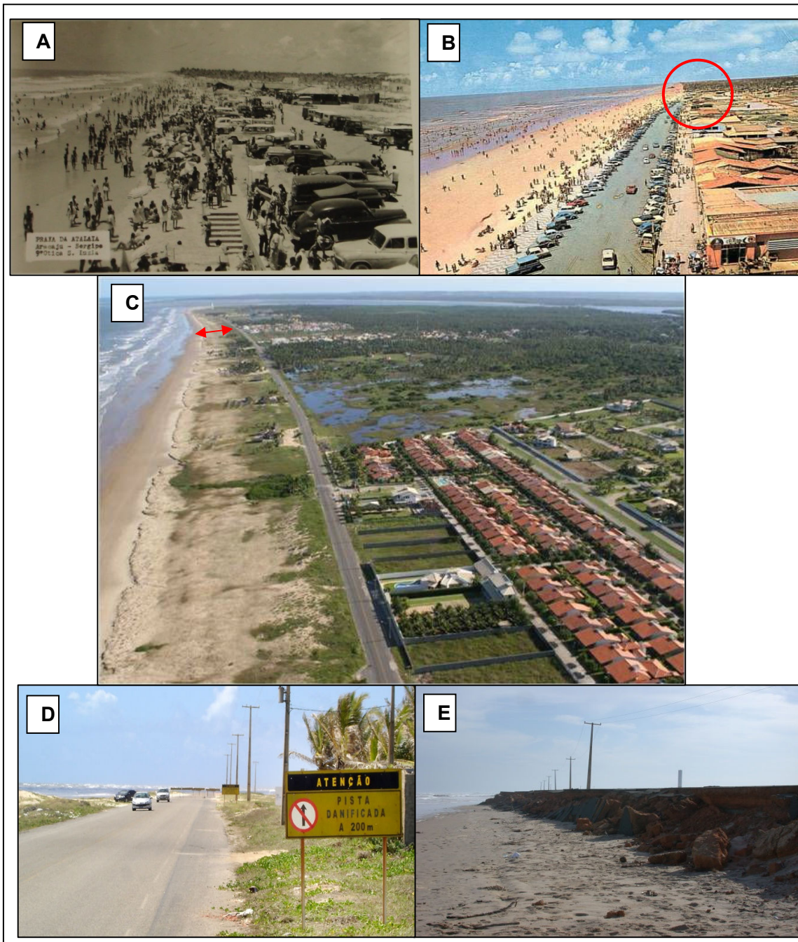
Figura 11: (a) Praia de Atalaia na década de 60 (Foto: Acervo A. Gentil); (b) Visão da praia de Atalaia anos 70/80, em destaque o local no qual a rodovia foi construída a rodovia (Foto: Arivaldo Azevedo); (c) Rodovia José Sarney década de 90 (Foto: autor desconhecido); (d) Visão da rodovia danificada, erosão iniciada em 2004 (Foto: Ascom DER); e (e) Pista destruída em 2006 (Foto: da autora).
