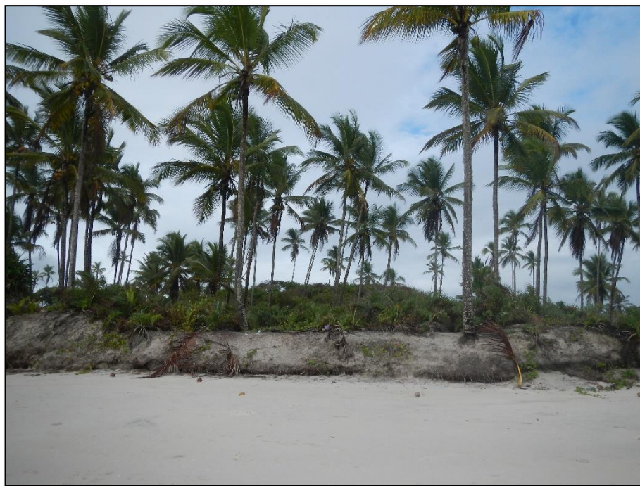
Foto 7 – Escarpa erodida dos Terraços Marinheiros Holocênicos, trecho entre a Praia de São Domingos e Praia do Mar e Sol.
