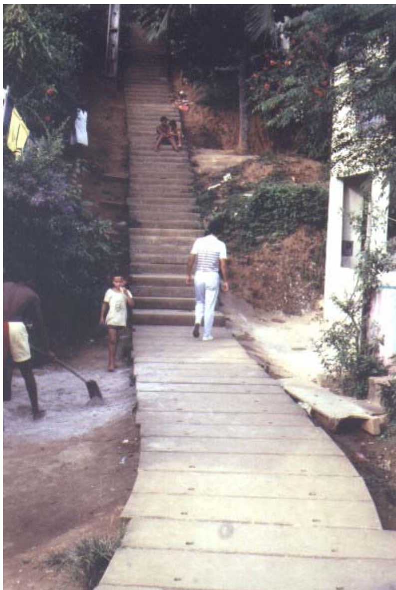
Foto 10 – Escadaria e Rampa Drenante em Antônio Balbino
