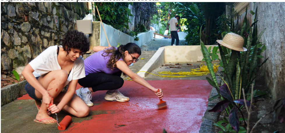
Figura 09: Pintura do piso no trecho da escola
