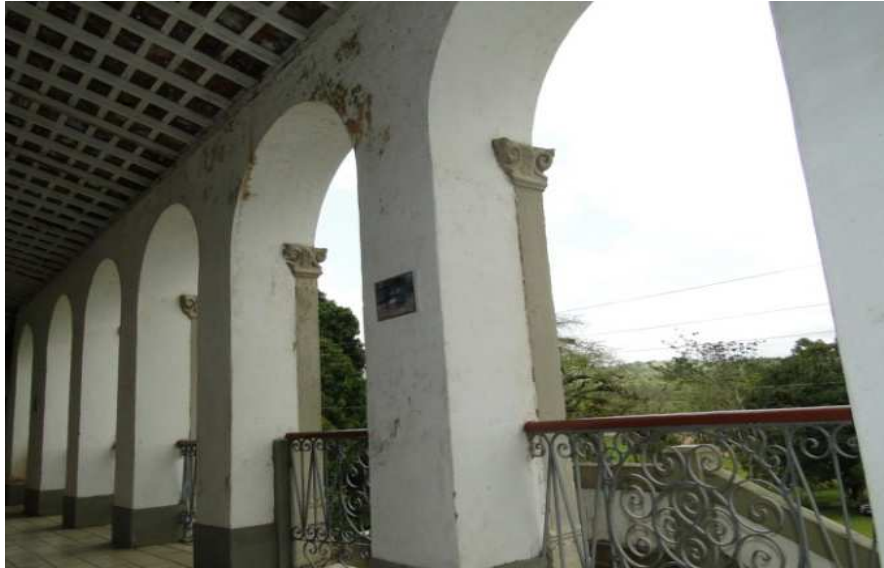
Figura 04 – Alpendre frontal visto a partir do canto direito. Destaque para os arcos em alvenaria.
