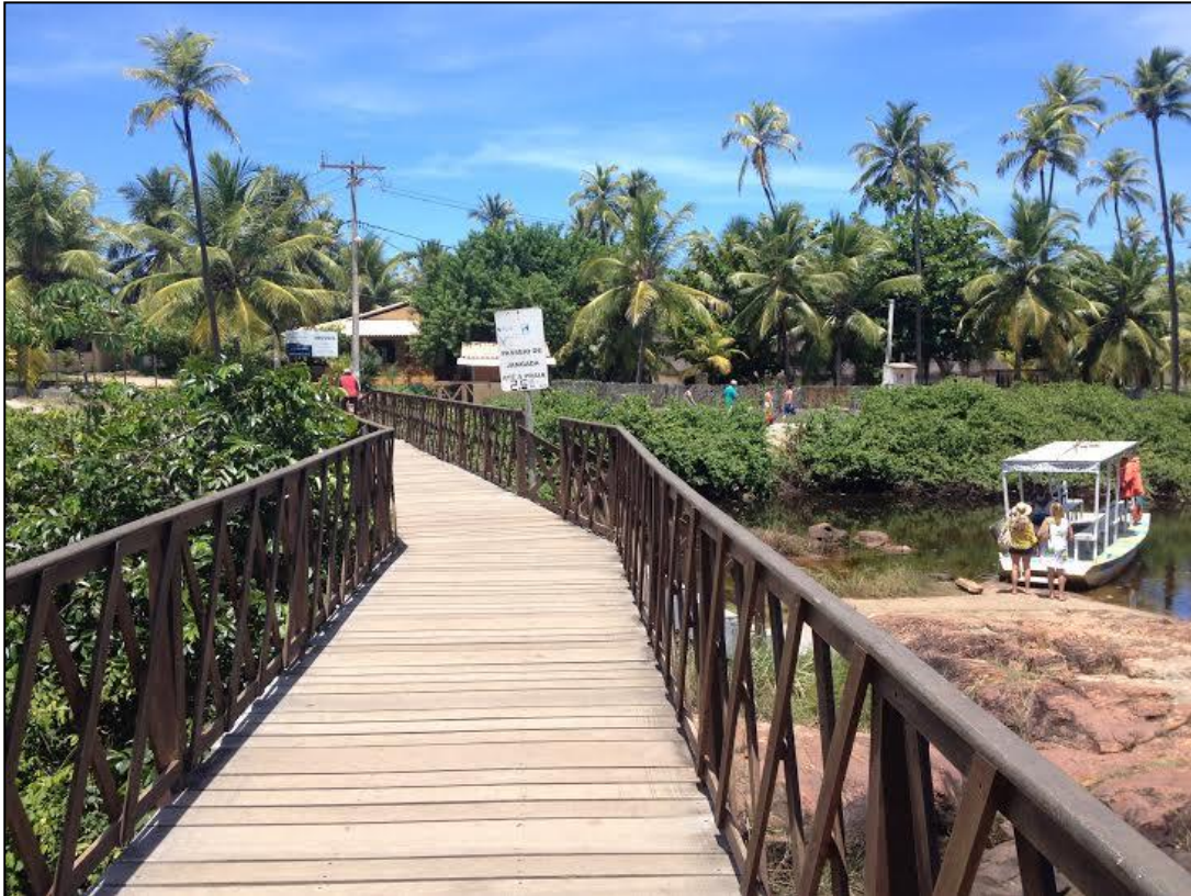
Figura 7 – Passarela no rio Imbassaí - 2014
