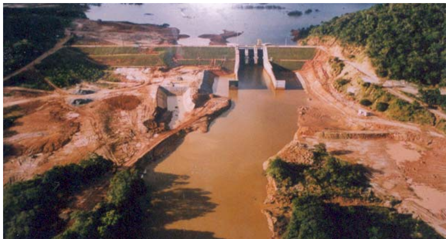
Figura 2 - Vista aérea da Barragem de Santa Helena (Rio Jacuípe) de jusante para montante, após a sua reconstrução (Foto: EMBASA).
