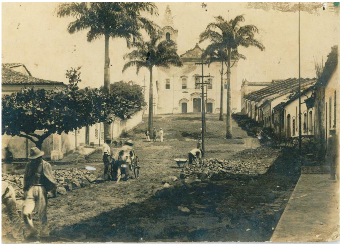
Figura 5 – Ladeira do Monte ainda com as palmeiras imperiais, durante obras de pavimentação, s/d. Fonte: Acervo Eivaldo Brito.
