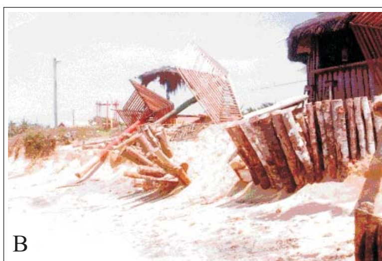
Foto 83 - A) Escarpa erosiva nos terraços holocênicos e B) Barraca ameaçada pela erosão em Prado (Seg. 25, Fig. 19) (Foto A de J. M. L. Dominguez).
