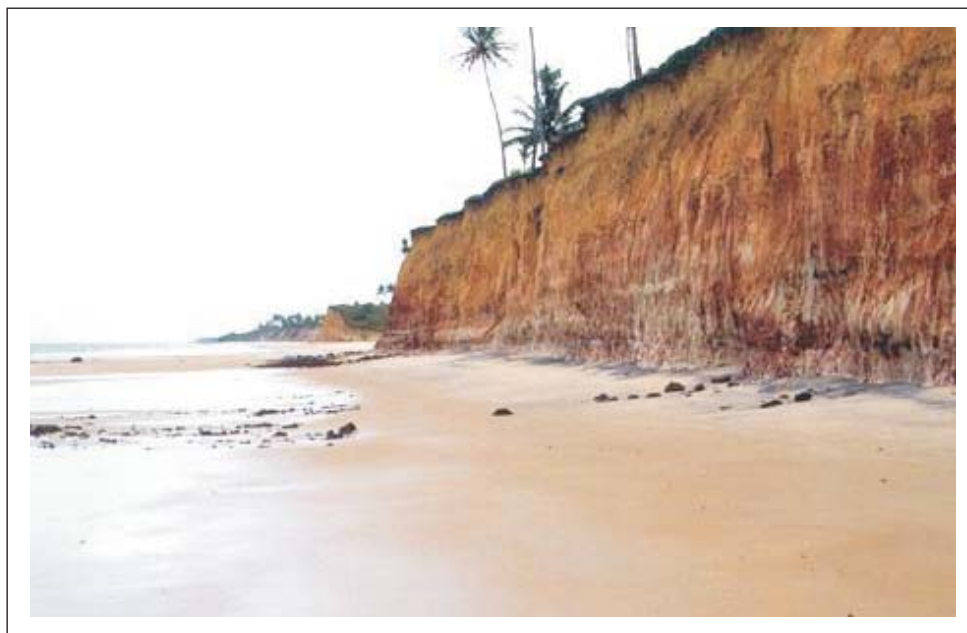
Foto 35 - Falésia com risco de desabamento (Risco A) entre Corumbau e Cumuruxatiba (Fig. 15) (Foto de J. M. L. Dominguez).
