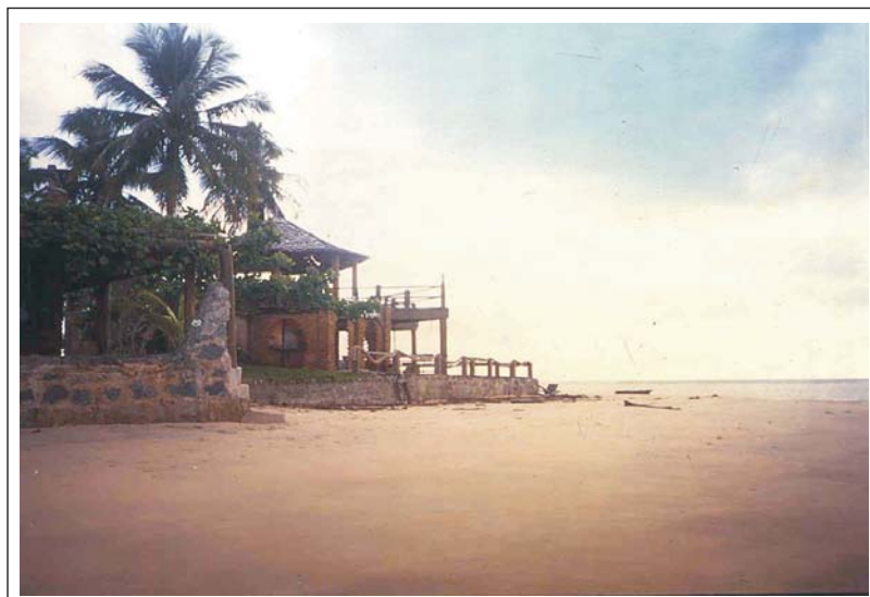
Foto 19 - Construção dentro da zona de atuação das marés em Porto Seguro (Fig. 13).
