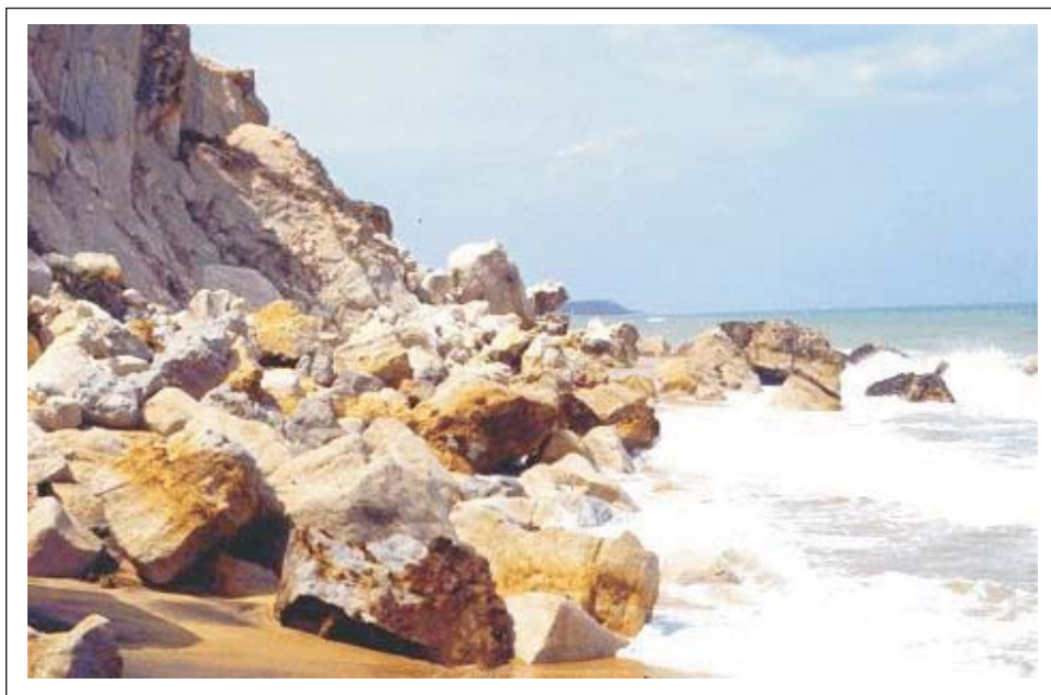
Foto 27 - Blocos desmoronados e quebrados sendo atacados pelas ondas na base de falésias areníticas ao sul da Ponta do Corumbau (Fig. 15).
