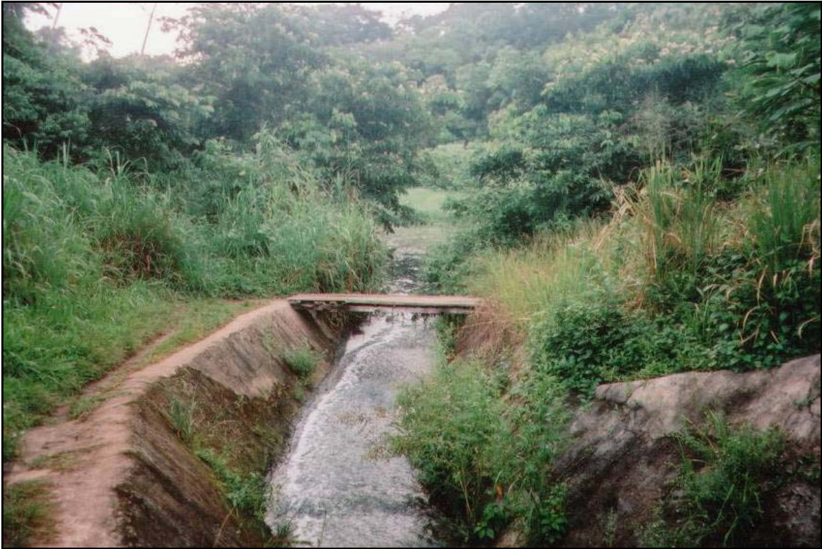
Fotografia 1.8 – Despejo de esgoto doméstico e industrial no Lago Bolonha (BORDALO, 2006).
