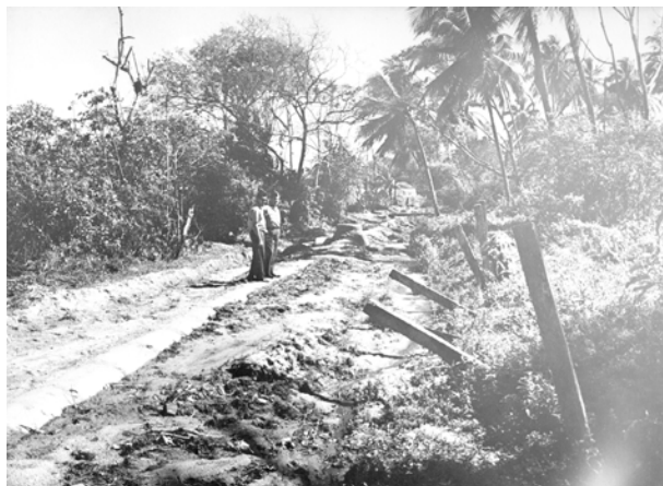
Figura 18 – "Corte" da Avenida Paulo VI - 1957
