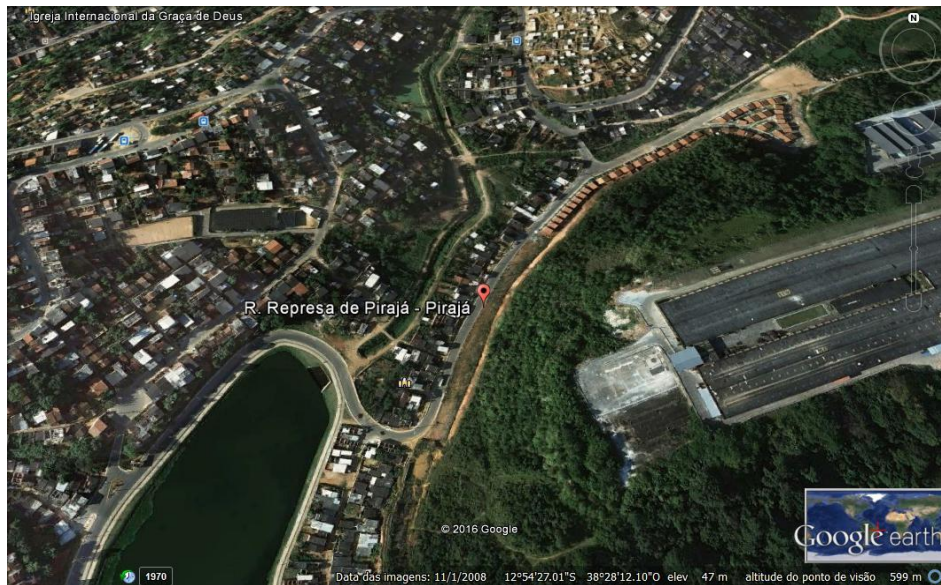
Figura 2 – Vista aérea da Rua da Represa de Pirajá - ao lado direito, o conjunto habitacional
