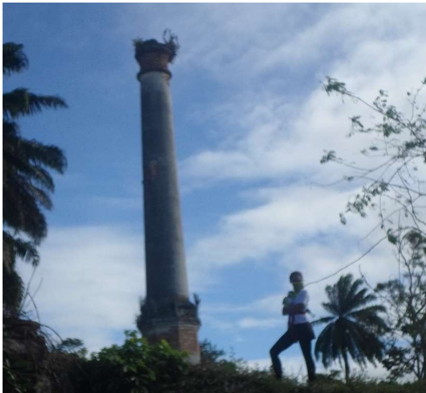
Figura 16 Chaminé da Cruz em meio às ruínas do Engenho
