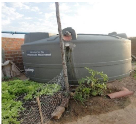
Figura 23 - Cisternas de polietileno - Ouro Verde
