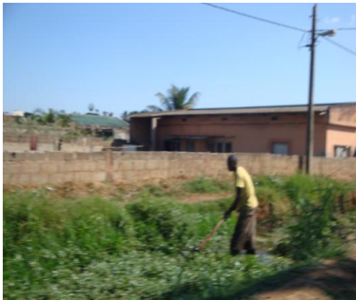
Imagem 6: Limpeza da vala. Fonte: Elaboração própria.
