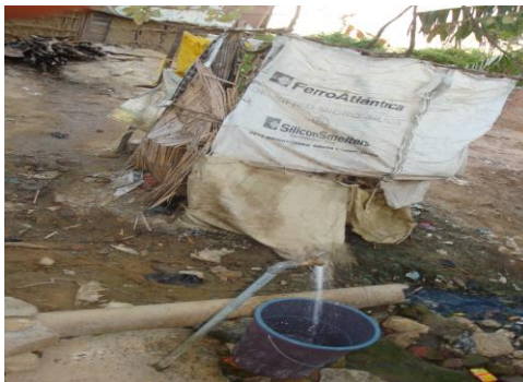
Imagem9: Latrinas e esgotos mesclados com a canalização de água-de consumo Fonte: Elaboração própria
