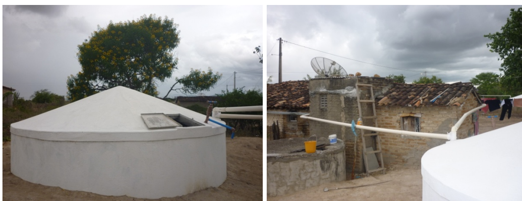
Figura 10 - Sistema de captação de água de chuva que cai nos telhados (Dir.)
