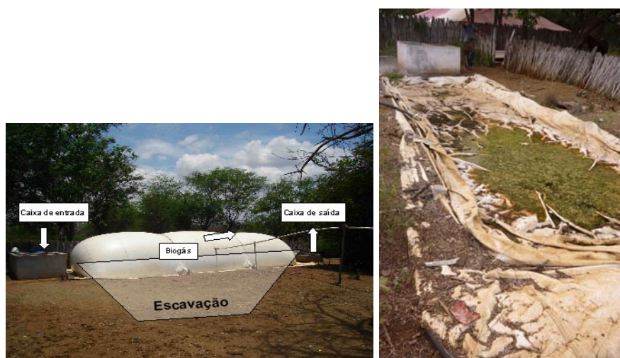
Figura 15 - Fotomontagem sobre funcionamento do biodigestor (Esq.) Figura 16 - Biodigestor desativado por falta de manutenção adequada (Dir.)
