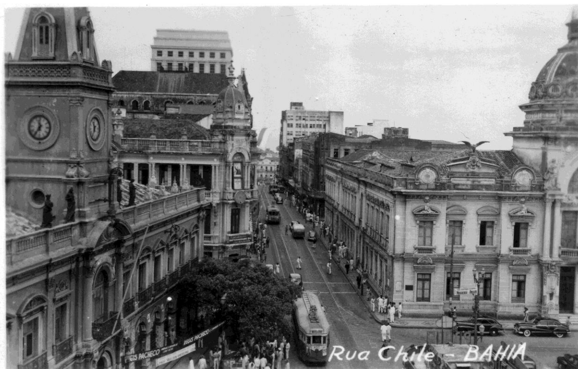
Figura 15 – Rua Chile, Casa dos Governadores (à direita) – Salvador, Bahia
