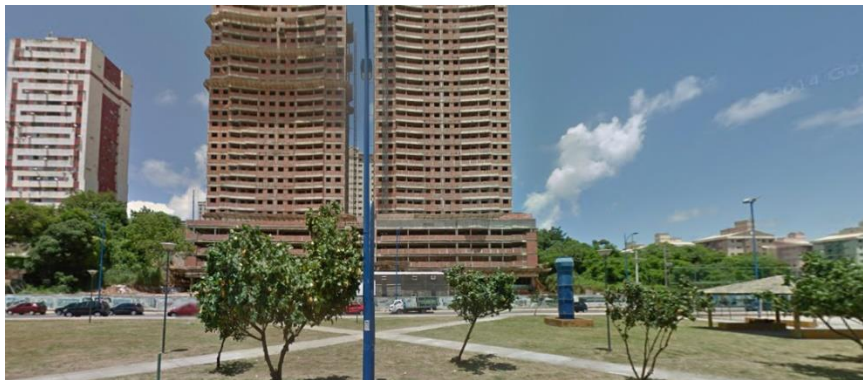
Figura 21 – Obras do Empreendimento Green Life Imbuí
