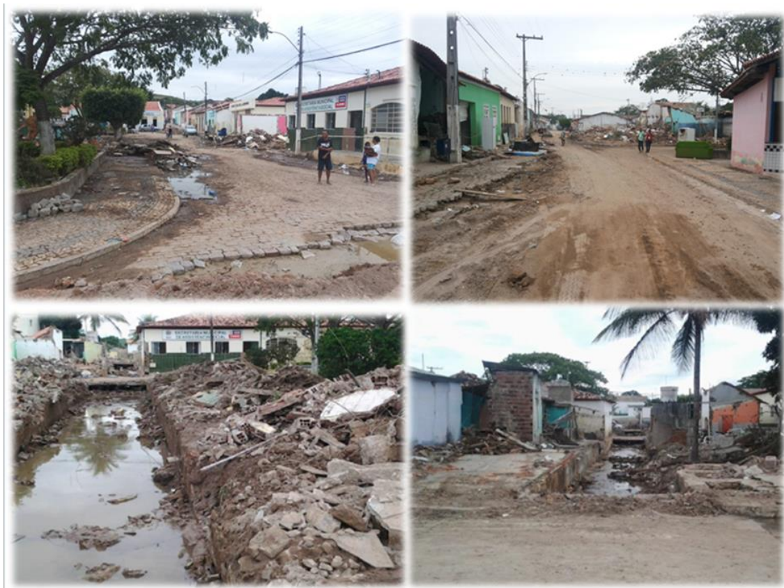
Figura 17: Destruição na cidade de Lajedinho.
