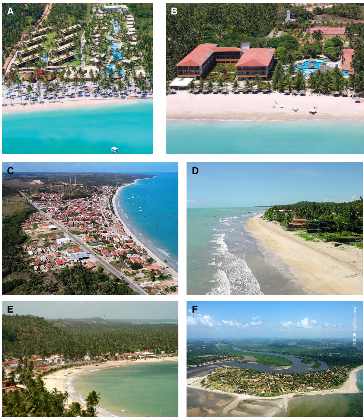
Figura 93 - Linhas de costa urbanizadas do Setor I (Estado de Alagoas): A – Hotel tipo resort em Maragogi (Foto Miramar Maragogi); B – Hotel de pequeno porte localizado próximo a zona de lavagem das ondas (Foto G. Fernandes); C – Casa (segunda residência) construída próxima a zona de lavagem das ondas na praia de Maragogi (Foto G. Fernandes); D – Ocupação da linha de costa da cidade de Maragogi (Foto G. Fernandes); E – Ocupação da linha de costa da localidade de São Bento (Foto Engesoft); F – Ocupação da linha de costa no Pontal do Boqueirão (Foto L. Villanova) (ver figura 92 para localização).
