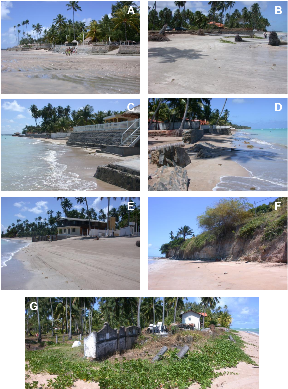
Figura 29 – Trechos costeiros condicionados à erosão da linha de costa: A – Muros de arrimo sobre a face da praia em Peroba; B – Coqueiros caídos em Peroba, note que o recuo da linha de costa neste trecho costeiro resulta no isolamento das construções sobre a face da praia; C – Muros de arrimo na linha de costa da praia de Barra Grande; D – Muros de proteção destruídos em Barra Grande, como resultado do recuo da linha de costa neste trecho costeiro; E – Casa sobre a face da praia em Barra Grande; F – Falésia ativa esculpida em rochas mesozóicas na praia de Japaratinga; G – Cemitério destruído pelo recuo da linha de costa na praia de Bitingui (ver figura 27 para localização).
