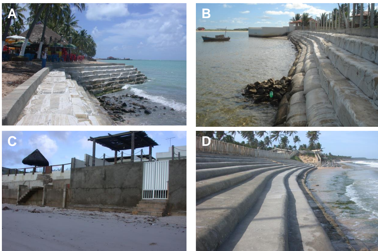
Figura 103 – Estruturas de proteção costeira observadas ao longo da linha de costa do Estado de Alagoas: A – Dissipador de energia na praia da Ponta Verde; B – Dissipador de energia na praia da Barra Nova; C – Muros de proteção na praia do saco da Pedra; D – Estrutura de proteção na praia do Pontal do Coruripe; (ver figura 101 para localização).
