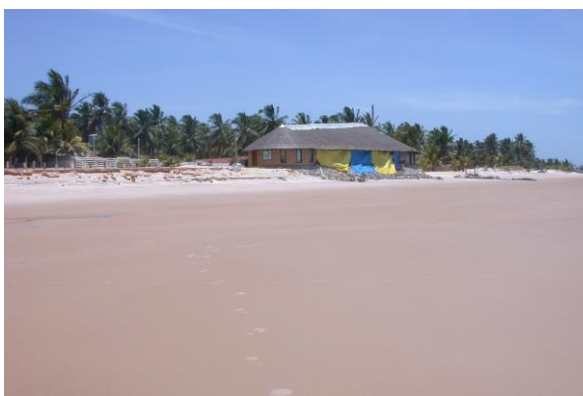
Figura 88 – Escarpa erosiva no terraço arenoso na praia de Miai de Cima.
