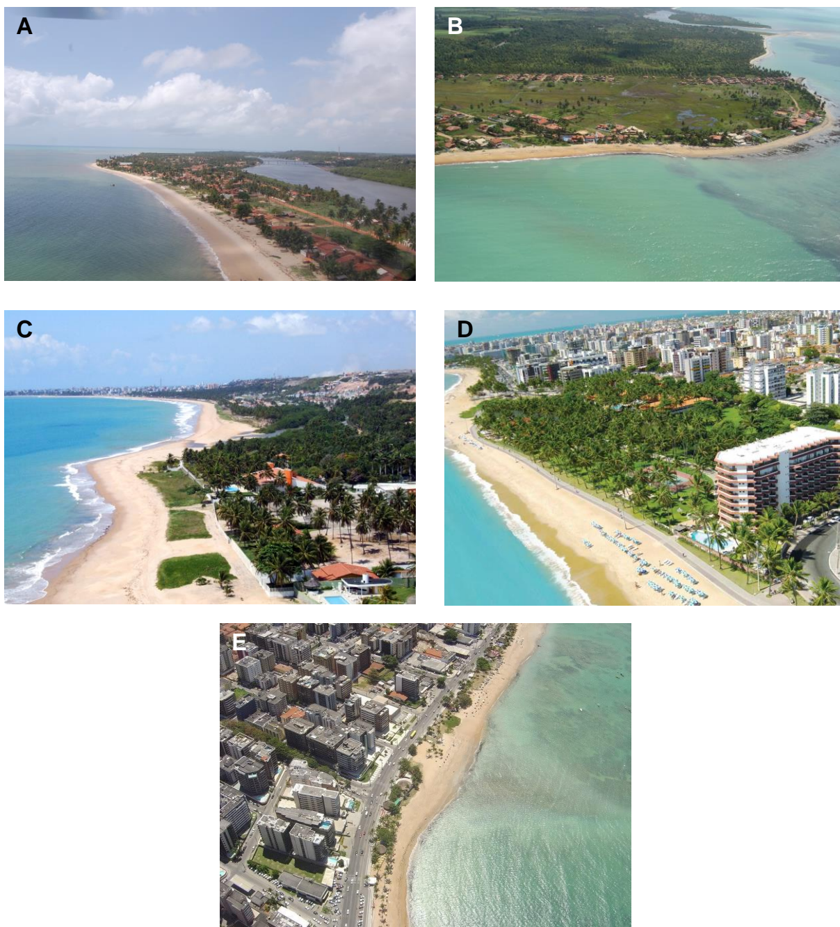
Figura 94 - Linhas de costa urbanizadas do Setor I (Estado de Alagoas): A – Urbanização da linha de costa na praia do Pontal da Barra (Foto J.C. Pereira); B – Ocupação urbana na linha de costa da praia de Tabuba (Foto F. Lucas); C – Ocupação urbana na linha de costa na praia de Jacarecica (Foto Rafiuskss); D – Hotel tipo resort na praia de Jatiúca (Foto L.L. Azevedo); E – Padrão de ocupação da orla de Maceió (Foto D.B. Cavalcante) (ver figura 92 para localização).
