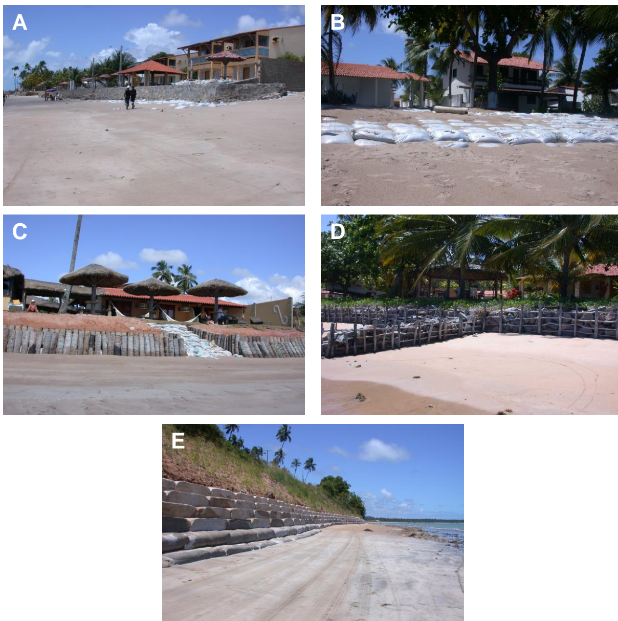
Figura 102 – Estruturas de proteção costeira observadas ao longo da linha de costa do Estado de Alagoas: A – Muros de arrimo na praia de Peroba; B – Sacos preenchidos por cimento na praia de barra Grande; C – Estruturas de proteção construídas com toras e aterro na praia de Maragogi; D – Estruturas de proteção na praia de Bitingui; Dissipador de energia na praia de Japaratinga (ver figura 101 para localização).
