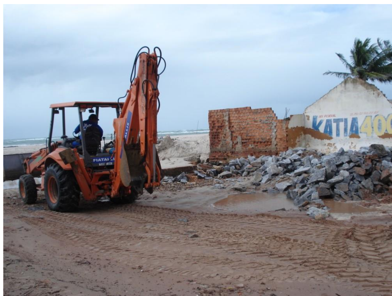
Figura 58 - Trator trabalhando para reerguer as estruturas de contenção destruídas após o evento erosivo que atingiu a Barra Nova na madrugada do dia 01/08/2009 (jornal “Alagoas em Tempo Real”, edição do dia 01/08/2007).
