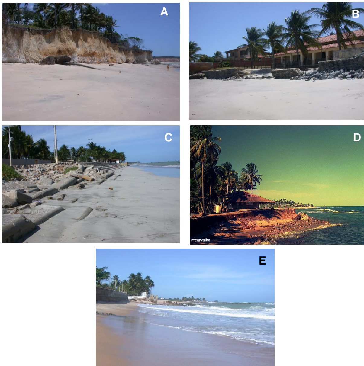
Figura 83 – Morfologias costeiras e/ou obras de proteção observadas em locais onde há focos de convergência de onda de uma ou mais direções (E, SE e S): A – Falésia ativa na Formação Barreiras na praia do Carro Quebrado; B – Obras de proteção destruídas na praia do Pontal da Barra; C – Estrutura de contenção destruída na praia de Paripueira ; D – Destruição parcial de imóvel na linha de costa da praia do Pratygy na década de 80 do século passado (Foto: R.T. Carvalho); e, E – Destruição de imóvel na linha de costa da praia do Pratygy na atualidade (ver figuras 81 e 82 para localização).
