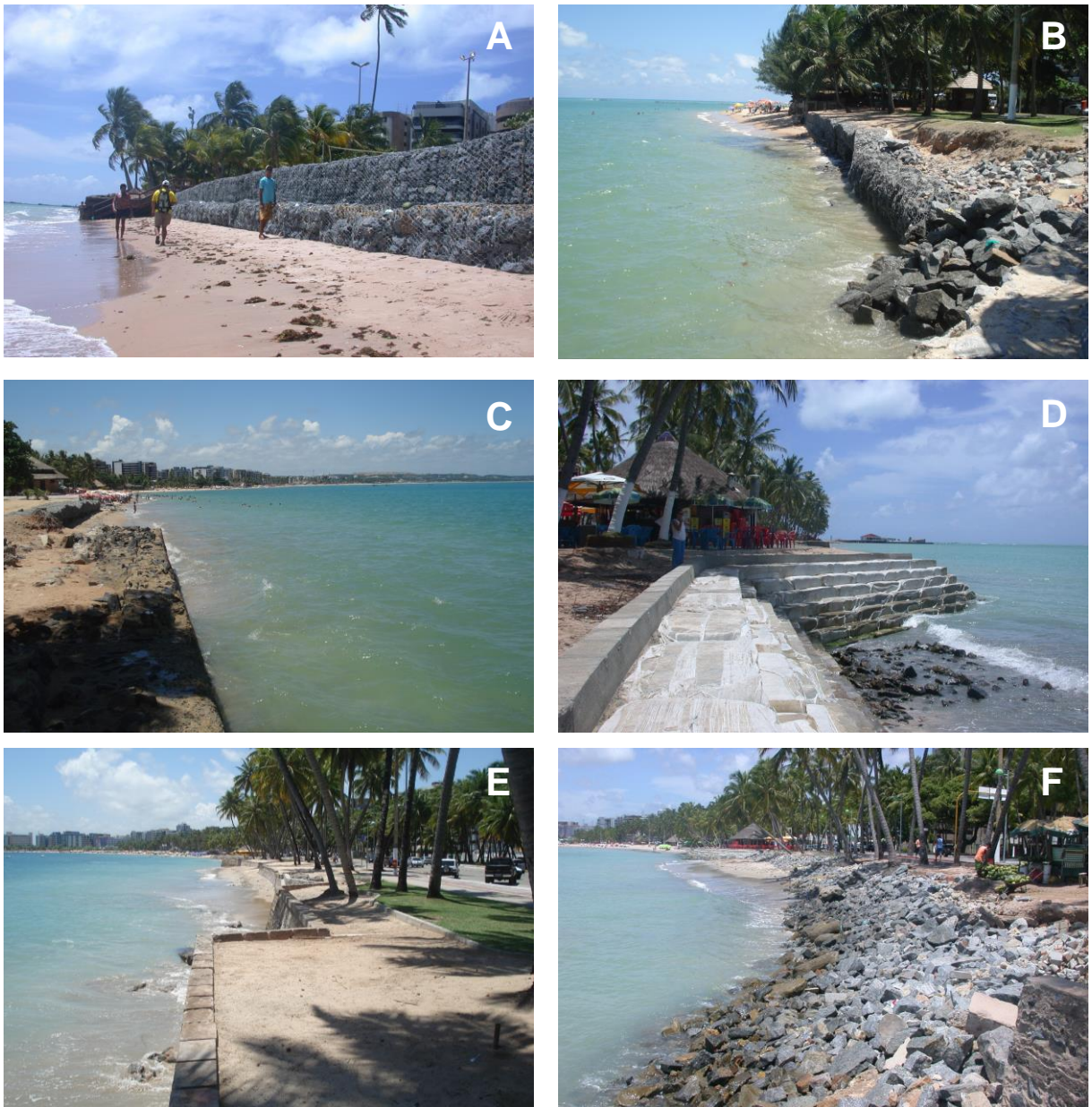
Figura 31 - Trecho costeiro condicionado à erosão da linha de costa na praia da Ponta Verde, onde são observados vários tipos de estruturas de proteção costeira que restringem o uso da praia recreativa durante a preamar de sizígia: A – Gabiões; B – Gabiões; C – Muros de arrimo; D – Dissipador de energia conhecido como “bag wall”; E – Muros de arrimo; F – Enrocamentos (ver figura 27 para localização).
