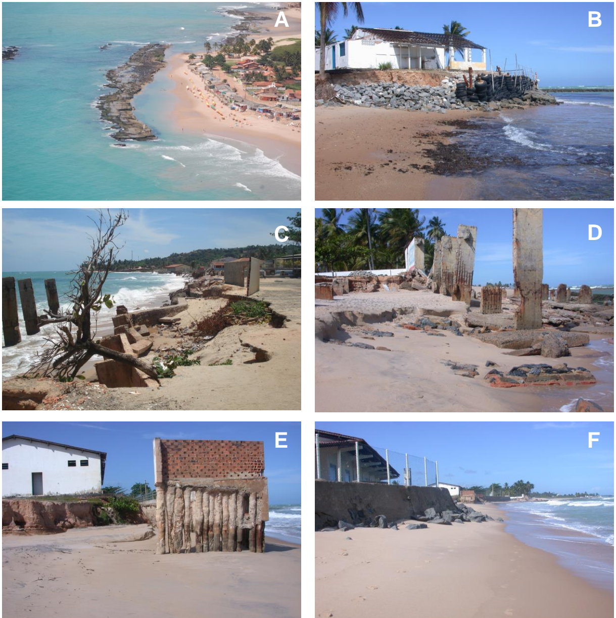
Figura 39 - Trecho costeiro condicionado à alta variabilidade da linha de costa nas proximidades da foz do rio Pratagy: A – Vista aérea da praia da Sereia (Fig. 46) (Foto J.C. Pereira); B – Imóvel parcialmente danificado na foz do rio Pratagy; C – Imóvel destruído na praia do Pratagy; D – Imóveis danificados na praia do Pratagy; E – Imóveis na linha de costa na praia do Pratagy (ver figura 27 para localização).
