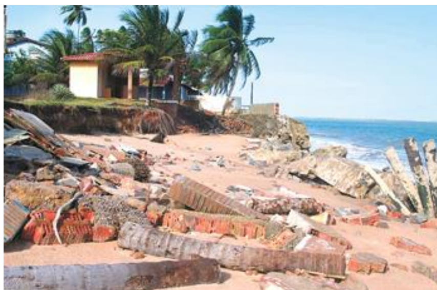
Figura 70 - Casas totalmente destruídas em Barreiras do Boqueirão, após os eventos erosivos ocorridos nos dias 12 e 13 de agosto de 2010 (jornal “Gazeta de Alagoas”, edição do dia 15/08/2010).
