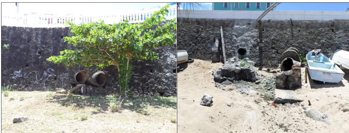
Figura 30 – Galerias de drenagem de águas pluviais na orla do Rio Vermelho
