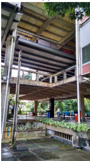
Figura 55 – Bloco A: (a) vigamento, (b) painel divisório e equipamentos do mezanino
