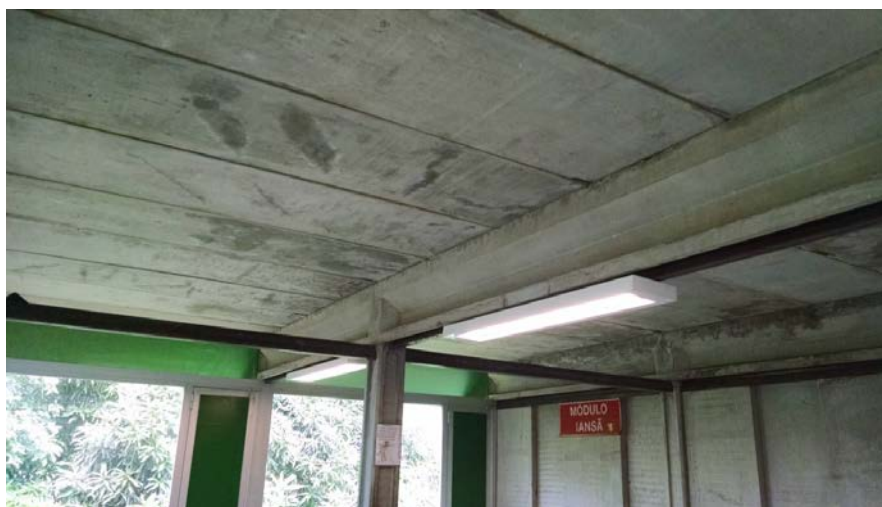
Figura 61 – Estrutura pré-moldada – PPG-AU
