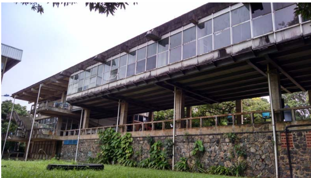
Figura 52 – Mezanino bloco A
