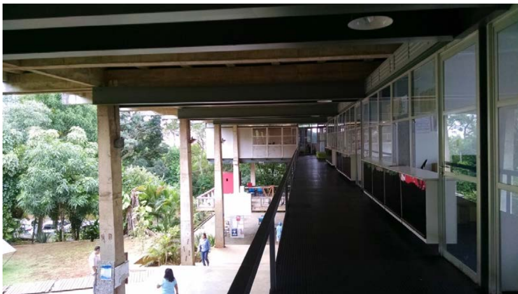
Figura 53 – Mezanino (divisórias das salas da Administração)
