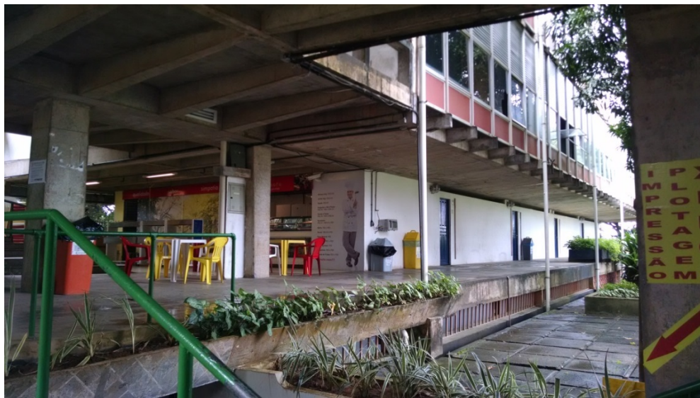
Figura 58 – Laje com preenchimento e com vazios (bloco A)
