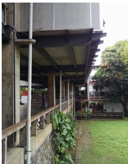
Figura 59 – Bloco A: (a) vigas do mezanino, (b) parede em tijolinho formando elementos vazados
