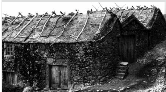
Foto 1.7 Casa de pedra com cobertura em colmo. Melgaço, Castro Laboreiro. Fonte: Oliveira e Galhano (1992, foto 41). v
