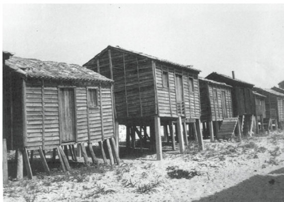
Foto 1.39 Casas de madeira sobre estacas, Palheiros da Tocha, Cantanhede. Fonte: Oliveira e Galhano (1992, foto 217).
