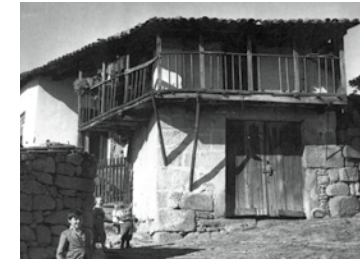
< Foto 1.13 Casa com varanda apoiada em esteios. Moncorvo, Castedo. Fonte: Oliveira e Galhano (1992, p. foto 50).
