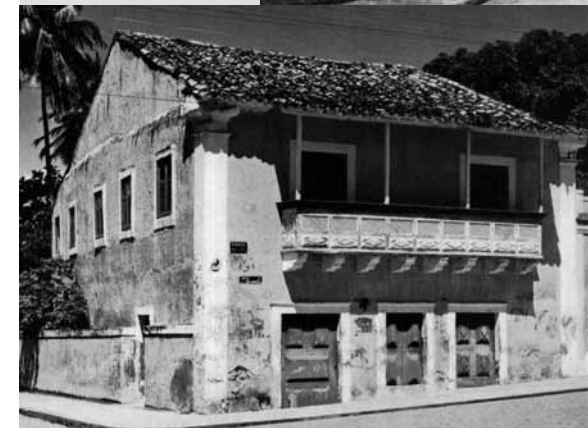
Foto 4.12 Casa com muxarabi parcialmente desmontado na Rua do Amparo em Olinda. Foto da autora. v
