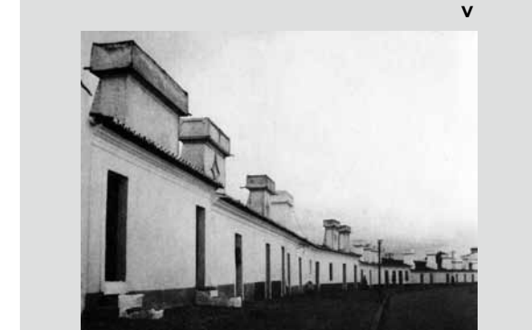
Foto 1.48 Aspecto de rua com chaminés na fachada. Povo de S. Vicente. Fonte: George et al. (1988, v. 3, p.80).
