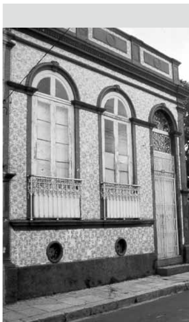
< Foto 4.45 Casa com revestimento de fachada em azulejos e características tipológicas do século XIX em Belém do Pará. Foto da autora.
