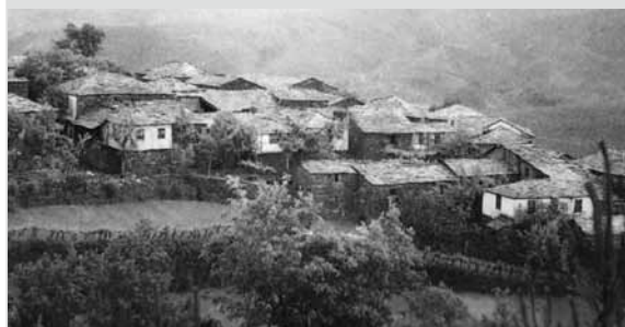
^ Foto 1.8 Conjunto de casas com telhados de lâminas de pedra em Castro Daire. Fonte: Oliveira e Galhano (1992, foto 37).
