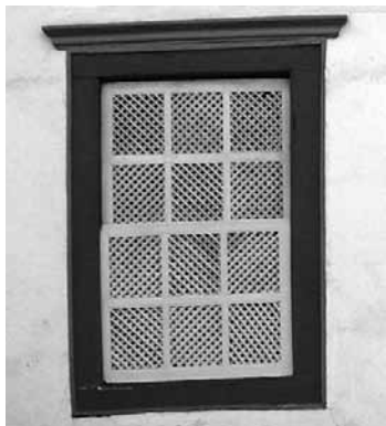
< Foto 4.20 Janela de guilhotina em treliça de madeira. Solução adaptada que eram adotadas no térreo. Mariana. Minas Gerais. Foto da autora.
