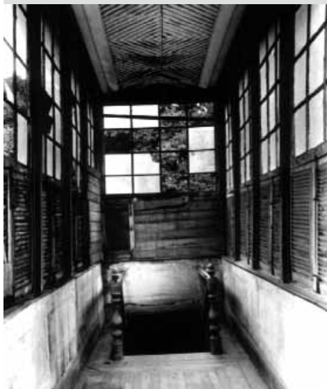
Foto 4.36 Corredor com solução combinada de ventilação através das venezianas a média altura e forro ripado em diagonais. Fonte: Arquivo da arquiteta Elna Trindade.
