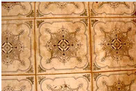
^ Foto 4.46 Peças de azulejos do século XIX, com manchas escuras resultantes do desenvolvimento de microflora sob o vidro, em Belém, Pará. Foto da autora.
