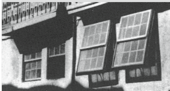
^ Foto 1.9 Detalhe de primitivas janelas de guilhotina sobrepostas externamente, Braga. Fonte: Antunes et al. (1988, v. 1, p. 94).
