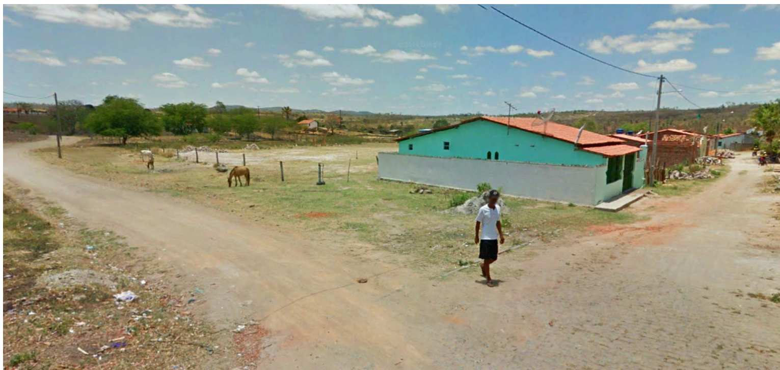
◀ Figura 14. Imagem do sítio de implantação com destaque para as casas residenciais de padrão simples à sua lateral (direita) e somente com um pavimento. Destaque também para o calçamento interrompido logo após finalizar a rua que dá acesso à Praça Dr. Castro Sintra. Fonte: Google Earth, editado pela autora (2017).
