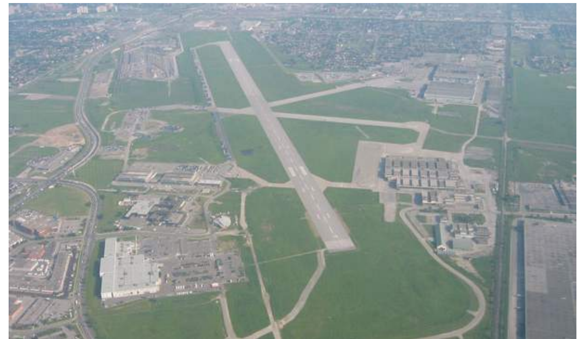
Antiga área militar desativada no subúrbio de Toronto Foto: PMA Landscape Architects
