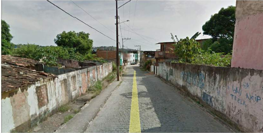
Situação atual da Rua da Paz de São João. Inexistência de vegetação, pavimentação irregular, ausência de sistema de drenagem Imagem: Google earth
