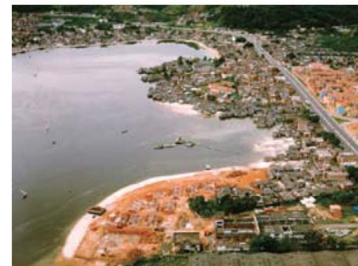
Vista de Boaideiro durante a intervenção e depois com a pista de borda construída Foto: CONDER
