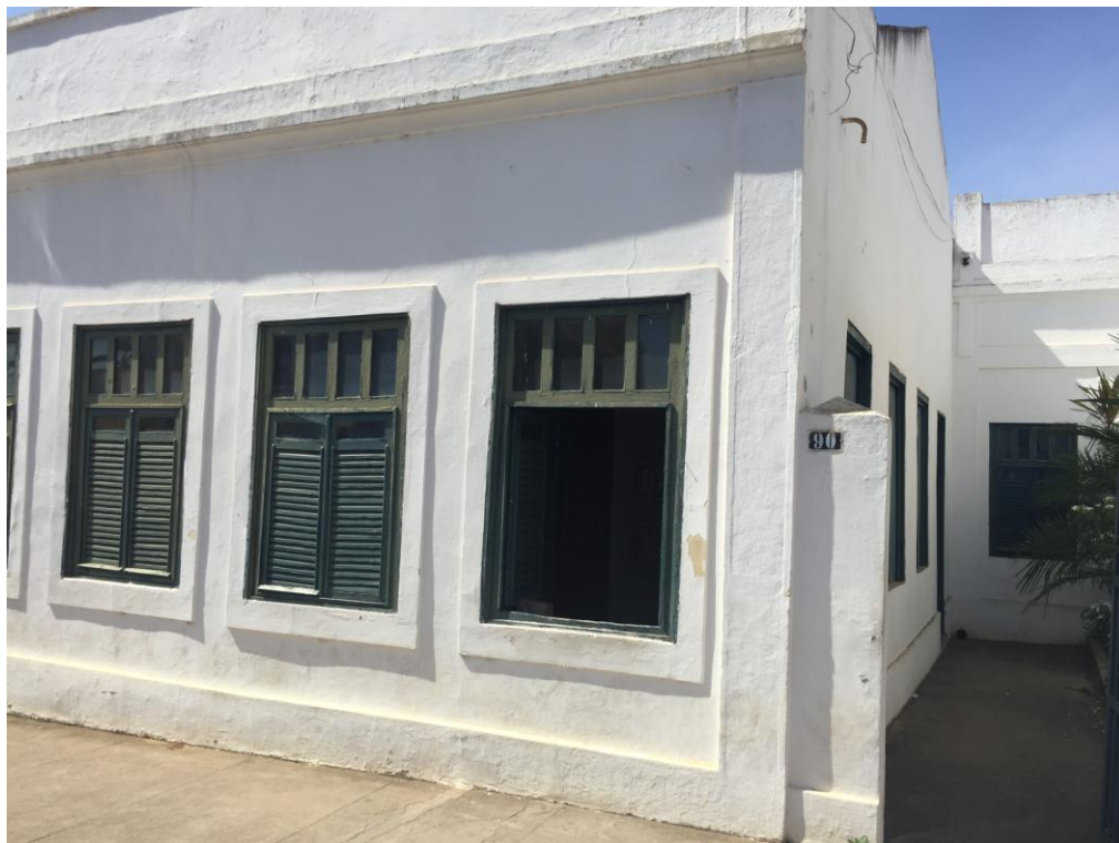
Figura 3: Vista frontal-lateral da Casa Museu Graciliano Ramos, portão de entrada. Palmeira dos Índios.
