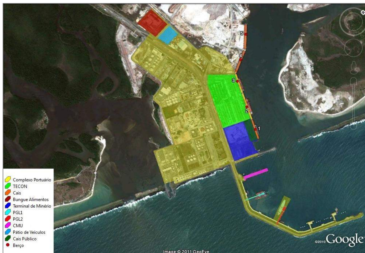
Figura 6 – Estrutura do porto de Suape na RMR
