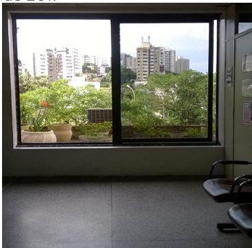
FIG.20 - Grandes vãos de ventilação
