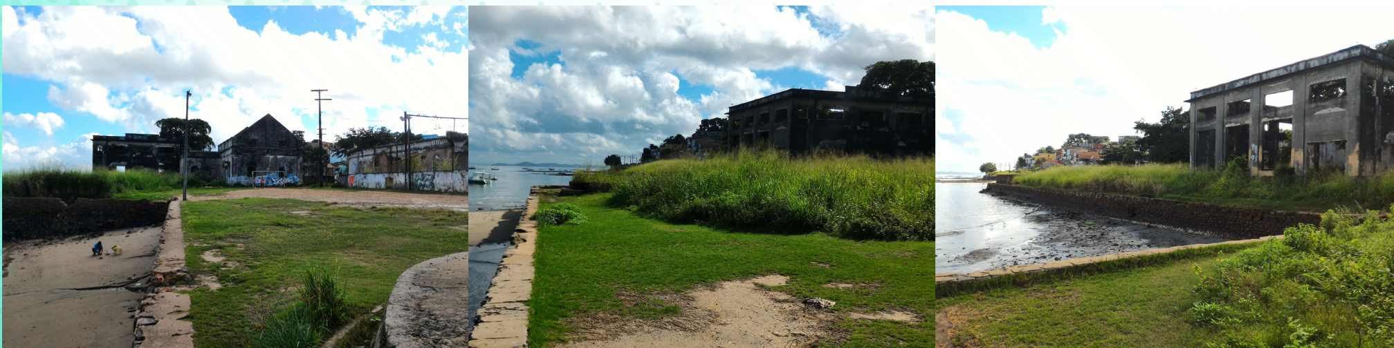
Fotos 10, 11 e 12: Vista da ruína do pavilhão marítimo da Fábrica São Braz. Rafael Rodamilans, 2017
