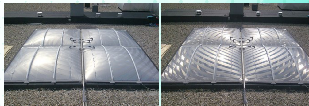
Imagem 32: Colchão de ETFE plotado para controle térmico e lumínico. Acesso e 20/11/2017. Disponível em: httpswww.buitink-technology.comukproductsshading-etfe-cushion-roofs
