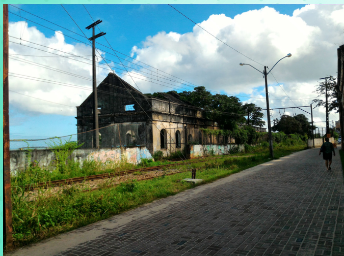
Foto 20: Vista do galpão marítimo da antiga Fábrica São Braz. Rafael Rodamilans, 2017
