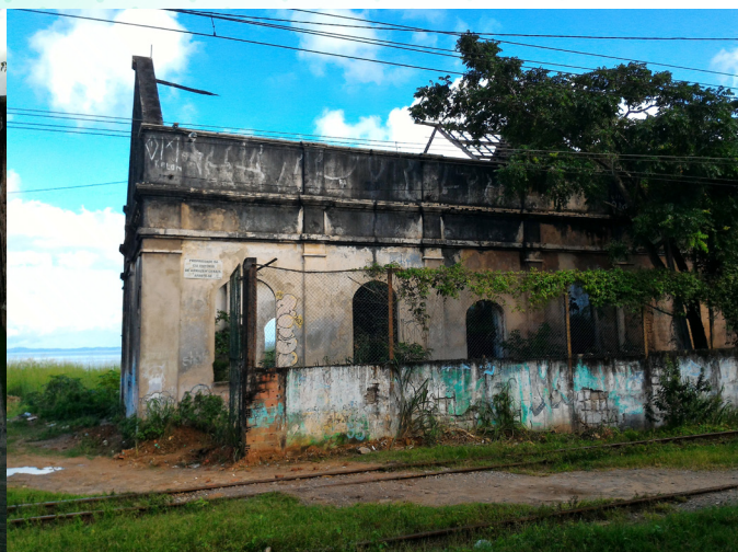
Foto 21: Vista do galpão marítimo da antiga Fábrica São Braz. Rafael Rodamilans, 2017
