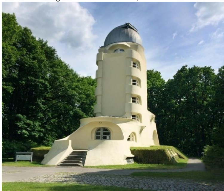
Figura 11: Torre Einstein, Alemanha.
