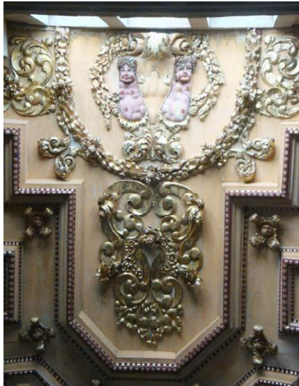
FIGURA 52 – Tritões a sudoeste no teto da nave. Fotografia de Belinda Neves
