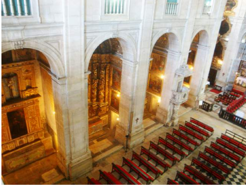
FIGURA 19 - Visão geral das capelas laterais pelo lado do Evangelho. Fotografia de Belinda Neves
