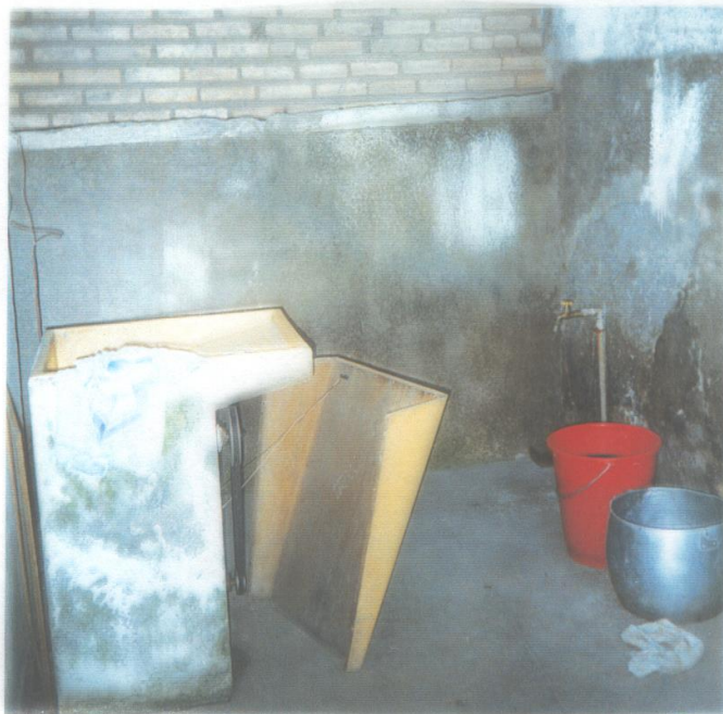
FOTO 14: Residência C - ponto externo de água.
