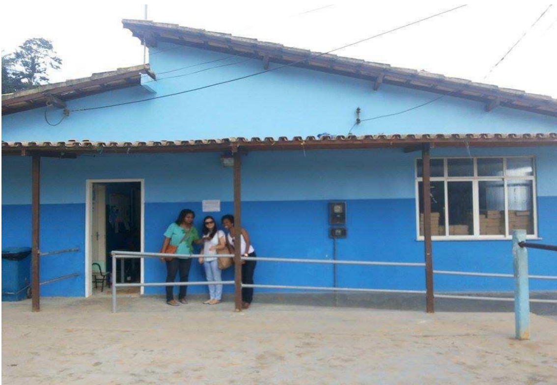
Figura 5 – Escola Municipal Nossa Senhora das Candeias, localizada na Rua da Caieira, Praia Grande, Ilha de Maré, Salvador-BA, 2014.
