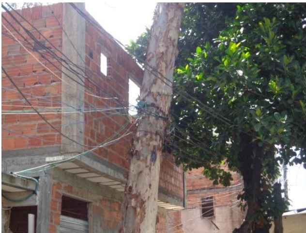
Figuras 18 e 19: Fornecimento de energia irregular na comunidade “Nova Esperança do Horto”.
