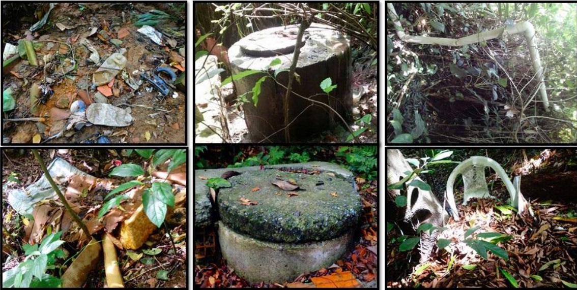
Apêndice 4: Imagens da poluição causada por resíduos sólidos, caixas de esgotos obstruídas e canalizações de esgoto na área do Parque.
