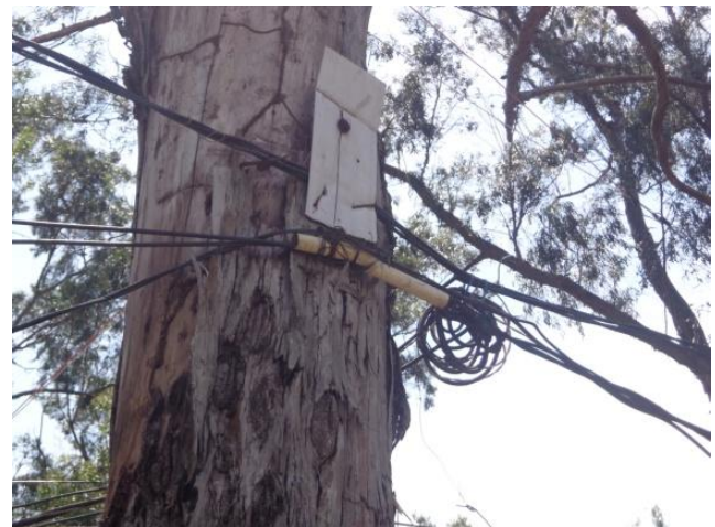
Figuras 18 e 19: Fornecimento de energia irregular na comunidade “Nova Esperança do Horto”.
