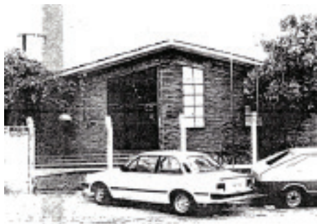
FIGURA 3 – FACHADAS FRONTAL E LATERAL DO PRÉDIO DA FACILA NO BAIRRO SÃO JOÃO, EM ARAGUAÍNA (TO)
