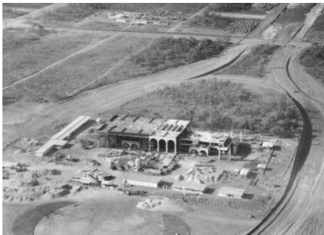
FIGURA 5 – A FOTOGRAFIA MOSTRA A CONSTRUÇÃO DO PALÁCIO ARAGUAIA, FUTURA SEDE DO GOVERNO ESTADUAL, NO CENTRO DE PALMAS, NO ANO DE 1990
