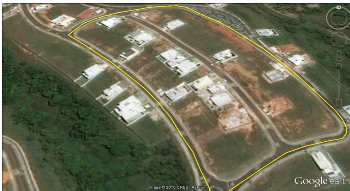
Figura 46 - Tecido urbano atípico, densidade de habitação, Camaçari, 17 UH/ha.
